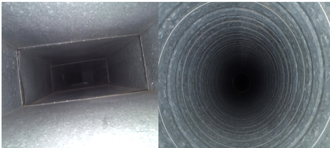
Kuvat 13-14. Yleiskuvat tuloilmakanavista.
