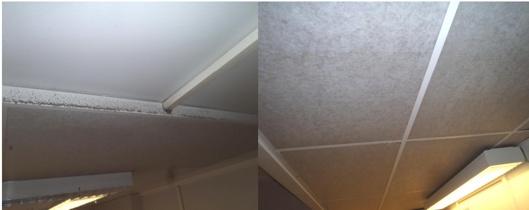
Kuvat 21-22. Akustolevyt ovat osittain pölyiset ja tummenneet.
