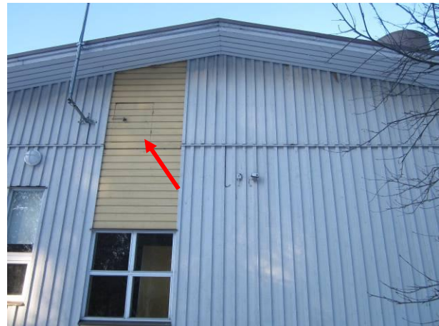
Kuva 12 Päätyseinä liikunta 30 -kohdalla, kulkuluukku yläpohjaonteloon.
