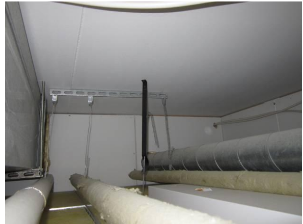
Kuva 34 Alakattotilaa ja LVIS-asennuksia.
