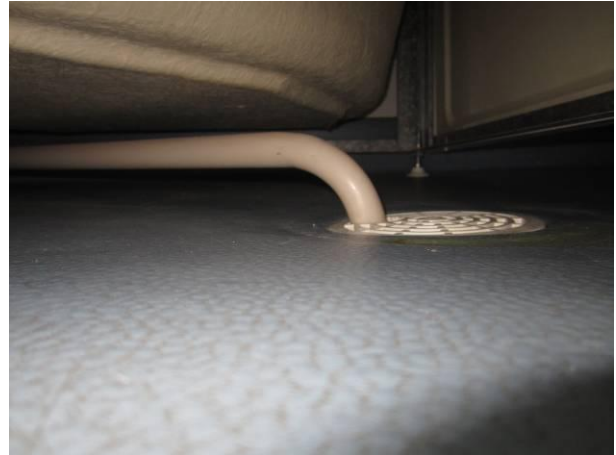
Kuva 28 Suihkualtaan alla oleva kaivo.
