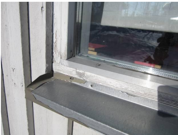
Kuva 13 Vesipellit ovat loivia.
