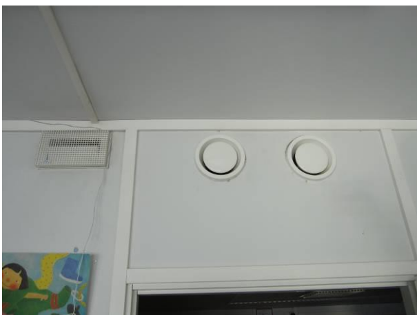
Kuva 35 Ryhmätilan IV-venttiiliejä.
