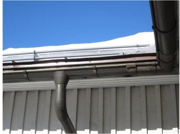
Kuva 18 Sisäpihan jiiritaite ja lumieste.
