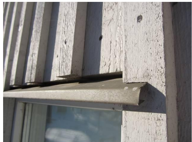
Kuva 14 Ikkunan yläpielen vesipelti.
