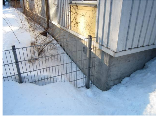
Kuva 6 Salaojien tarkastuskaivot olivat lumen peitossa.
