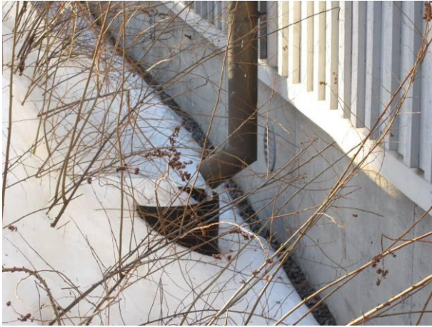
Kuva 5 Rännikaivo, sokkelin sepelivierus.
