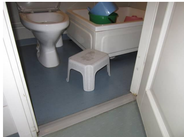
Kuva 10 Kynnyslistat ovat matalia.
