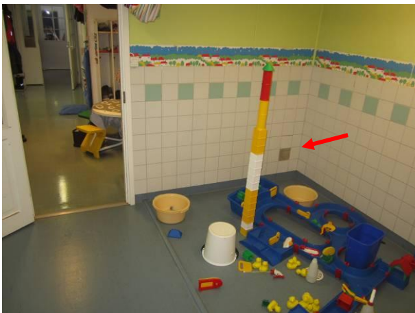
Kuva 25 Vesileikkihuone 40, irtolaatta.
