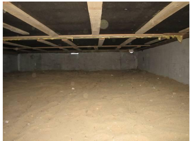
Kuva 20 Länsilohkon eteläpuoleinen alustatila ryhmähuone 3 alla. Kuivaa hiekkaa.
