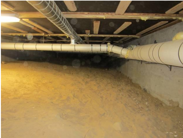
Kuva 9 Länsilohkon keskialueen alustatilaan eteisen 16 alla. Ilmanpoistokanava.
