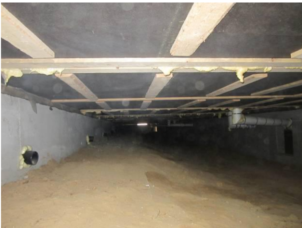
Kuva 5 Länsilohkon pohjoissivun alustatila leikki/ lepo huone 6 alla.
