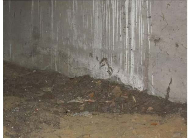
Kuva 18 Sisäänkäynnin tason laatan alla humusmaata ja lehtijätettä.
