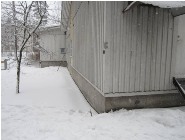
Kuva 1 Teknisen tilan kulma, pintakallistukset vaikuttivat riittävältä.
