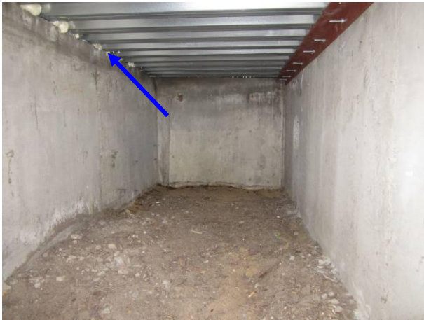
Kuva 23 Märkäeteisen 34 sisäänkäynnin alla pellin pinnassa oli kondenssia.
