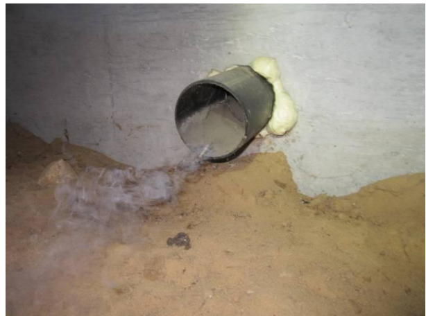
Kuva 6 Savulla varmistettu hyvä tuloilmavirtaus putkesta.
