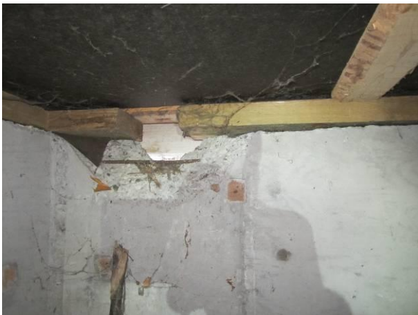
Kuva 11 Reikä alustatilaan länsilohkon itäpäädyssä leikki/ lepohuone 6 alla.
