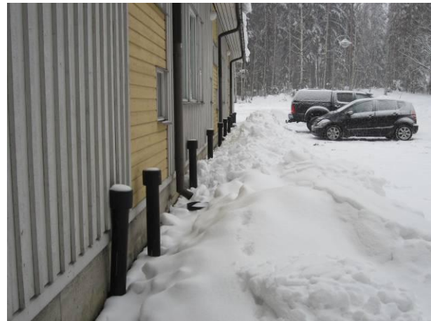
Kuva 2 Länsilohkon pohjoissivulla tuuletusputket, syöksytorvi ja rännikaivo.
