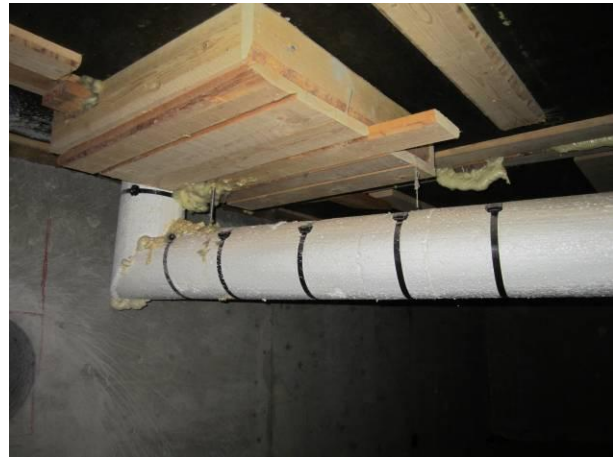
Kuva 24 Tyypillinen lattiakaivon lautakotelo, kuiva rakenne.
