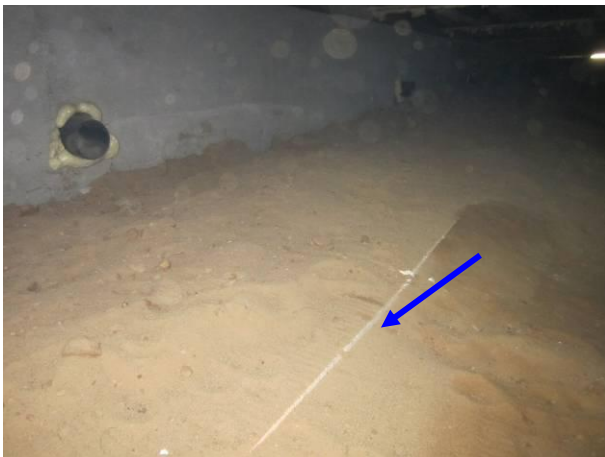
Kuva 19 Ulkoseinäreunoilla on hiekan alla roustaeristeenä polystyreenikaista.
