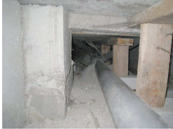
Kuva 30 Putkikanaalia keittiön suuntaan kuvattuna.
