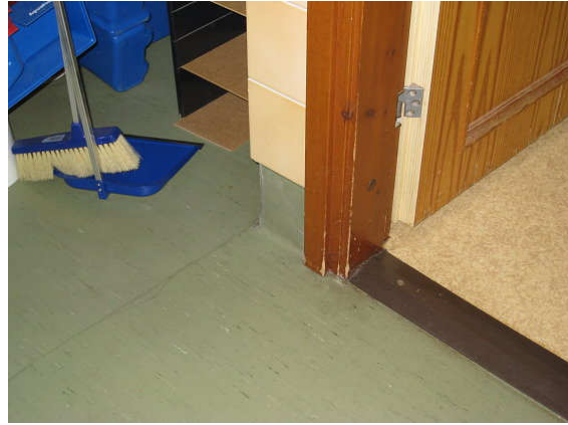
Kuva 18 Pesuhuonetilojen kynnykset ovat matalat.
