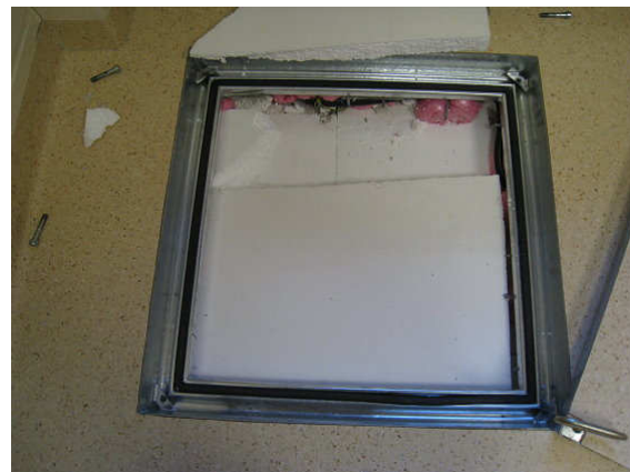
Kuva 28 Uusi lattialuukku putkikanaalin kohdalla tilassa 15.
