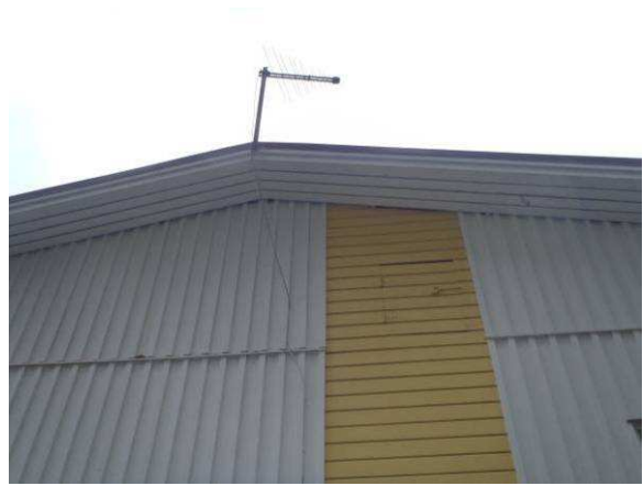
Harava-antennin kiinnitys on huono.
