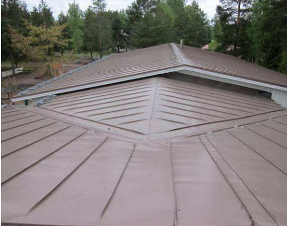
Yleiskuvaa vesikatolta, katemateriaali on kone-saumattu peltikate
