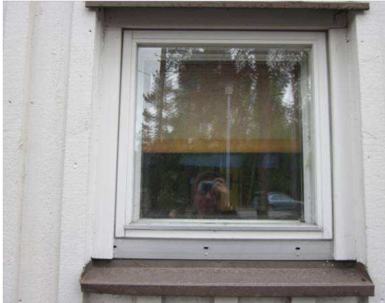
Rakennuksen ikkunat ovat alkuperäisiä puuikkunoita
