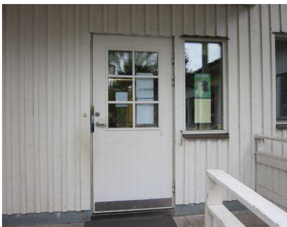
Ulko-ovet ovat yksilehtisiä puuovia
