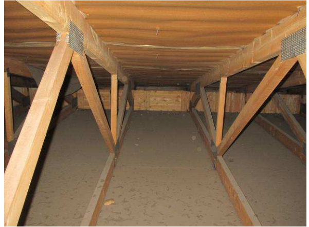
Kuvaa alaräystäältä, tuuletus alaräystäiltä OK
