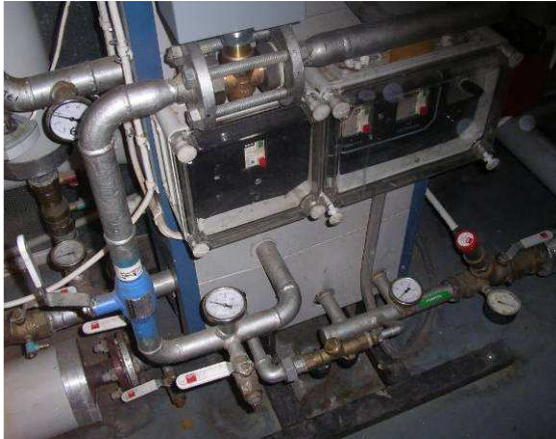
Lämmönsiirrinpaketti.
