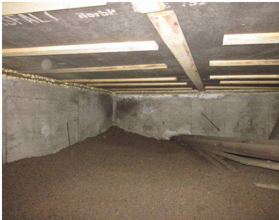
Alapohjatilassa ei havaittu poikkeavaa kosteutta eikä hajua
