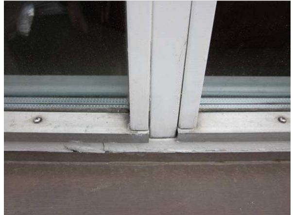
Ikkunoiden maalipinnat ovat vielä kohtuullisessa kunnossa
