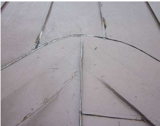
Jiirin saumoja on tiivistetty kittaamalla
