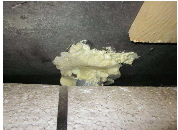
Läpiviennit on tiivistetty polyuretaanilla
