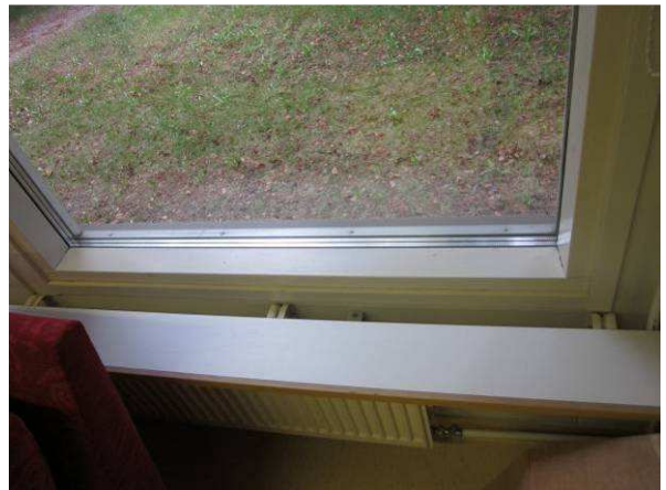
Suuremmat ikkunat ovat lämpölasielementtejä
