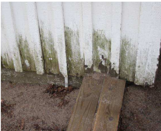
Piharakennuksen ulkoverhous turhan lähellä maanpintaa,-> tihentynyt kunnostustarve
