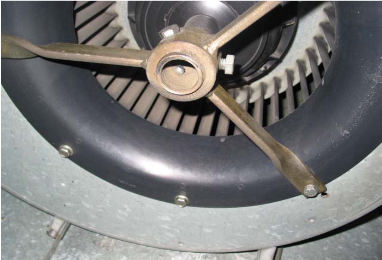
KUVA 3. Poistopuhaltimen laakerit pitävät melko kovaa ääntä.
