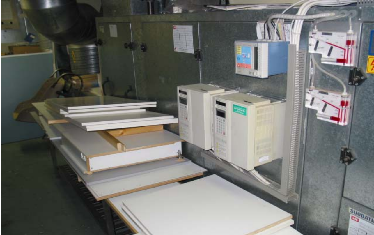
KUVA 1. Ilmastointikone on alkuperäinen Ilmaterän valmistama ns. pakettikone.
