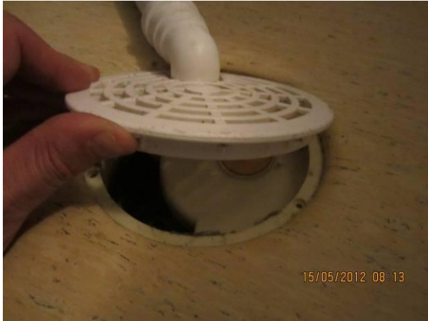
Kuva 15 Lattiakaivoliittymä on tiivis.
