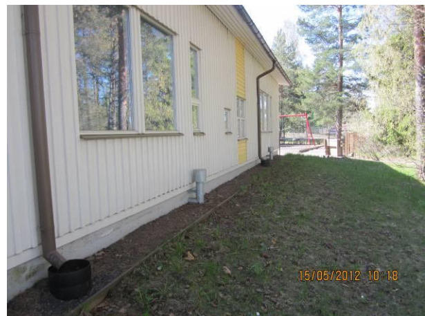
Kuva 2 Takasivun nurmialuetta, sepelireuna, kattosadevedet on johdettu rännikaivoihin. Kallistukset ovat ok.
