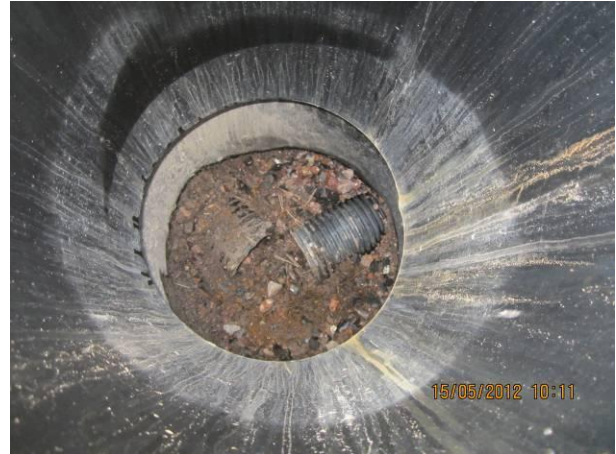
Kuva 8 Teknisen tilan 56 so-kaivon pohjalla soramaata, sokkelista juoksupintaan on n. 1,2 metriä.
