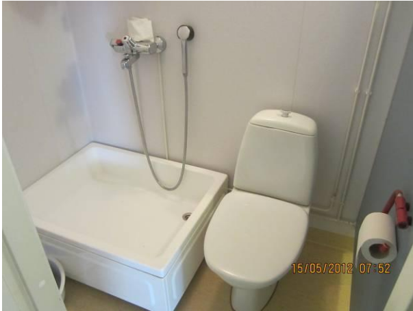
Kuva 41 Isojen lasten wc-suihkutila.
