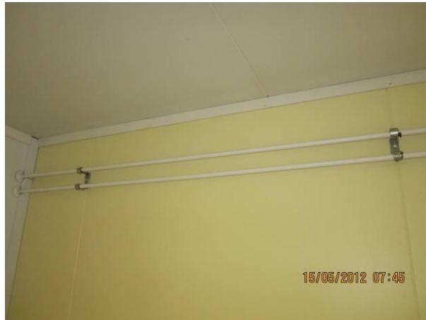
Kuva 50 Eristämättömiä lämpöputkia huone- loissa.
