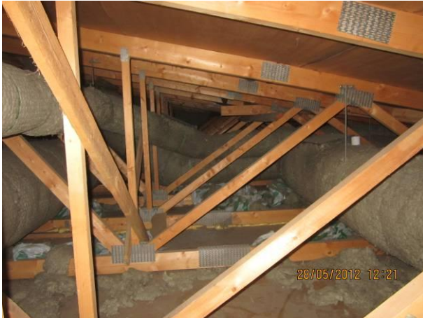
Kuva 31 Yleiskuva onteloon, rakennusjätettä.
