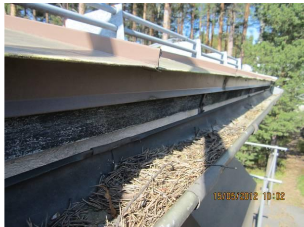
Kuva 30 Huonokuntoista räystäslautaa
