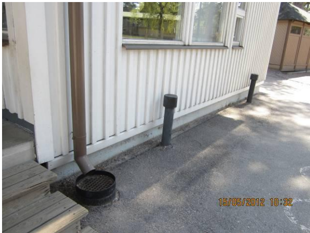
Kuva 3 Sisäänkäyntisivua, kaadot ovat ok.
