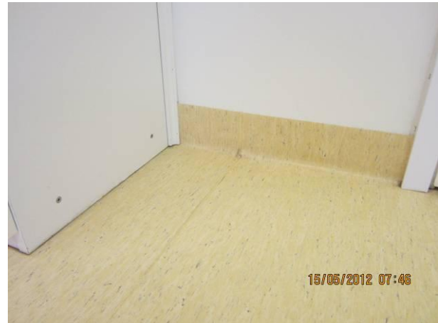
Kuva 18 Kuivissa huonetiloissa on muovimattojen juurinostot listojen tilalla.
