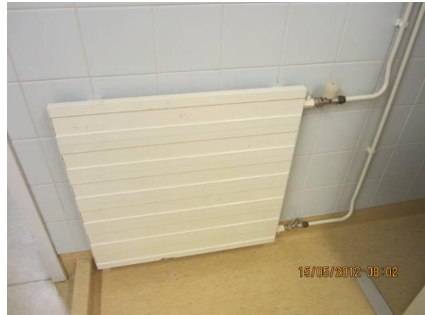
Kuva 12 Vesileikkitilan korotuslista, käyttövesipatteri.
