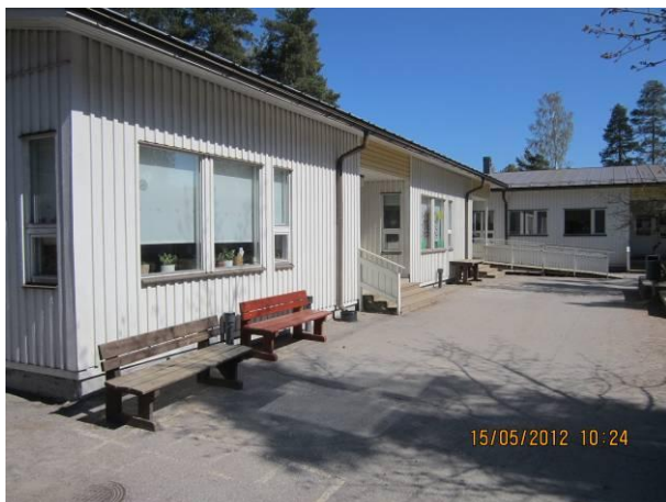
Kuva 1 Sisäpihalla asfaltin kaadot ovat kunnossa.
