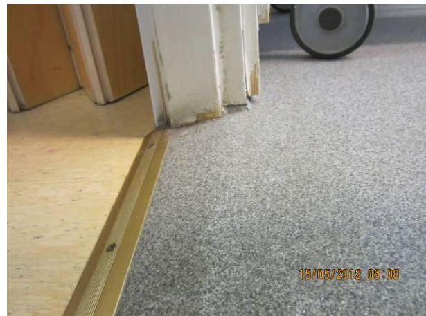
Kuva 14 Keittiön ovella ei ole kynnystä.
