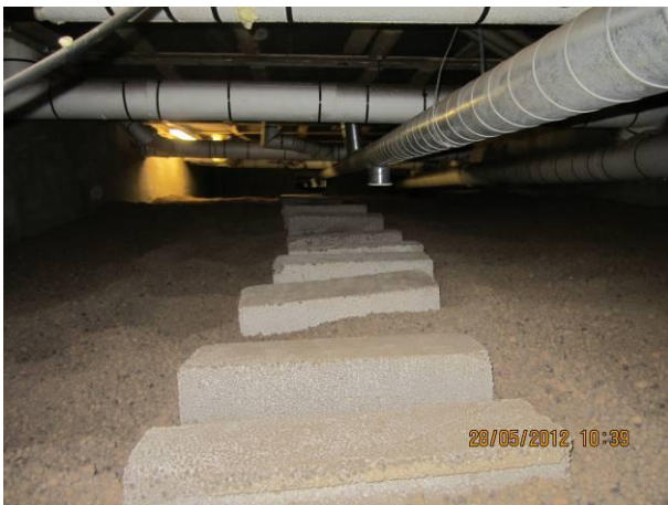
Kuva 9 Kunnossa olevaa alustatilaa, pohjalla on kevytsora. Pääreiteille on tuotu ks-harkot kulkutieksi.
