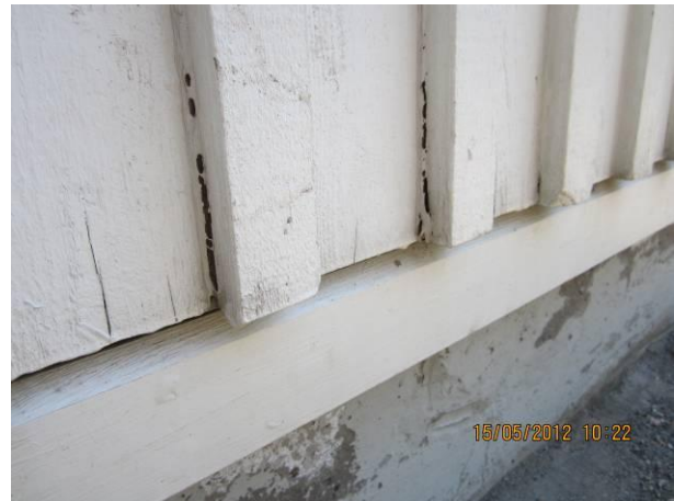
Kuva 20 Tiivistyskittauksia jo rikki..
