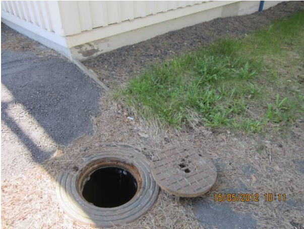
Kuva 7 Tarkastuskaivo teknisen tilan 56 kulmalla.
