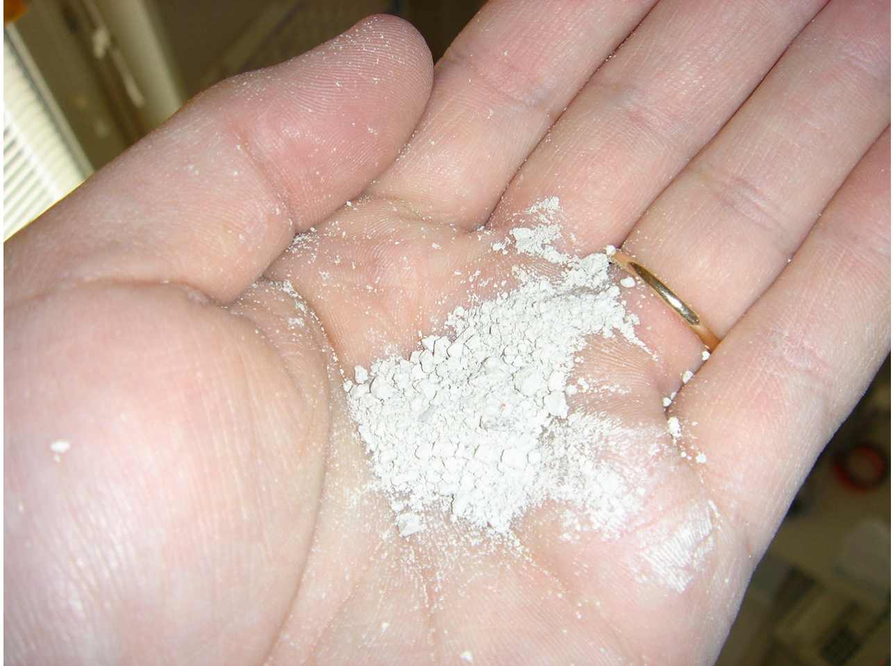
KUVA 14. Onteloissa on runsaasti hienojakoista betonipölyä.
