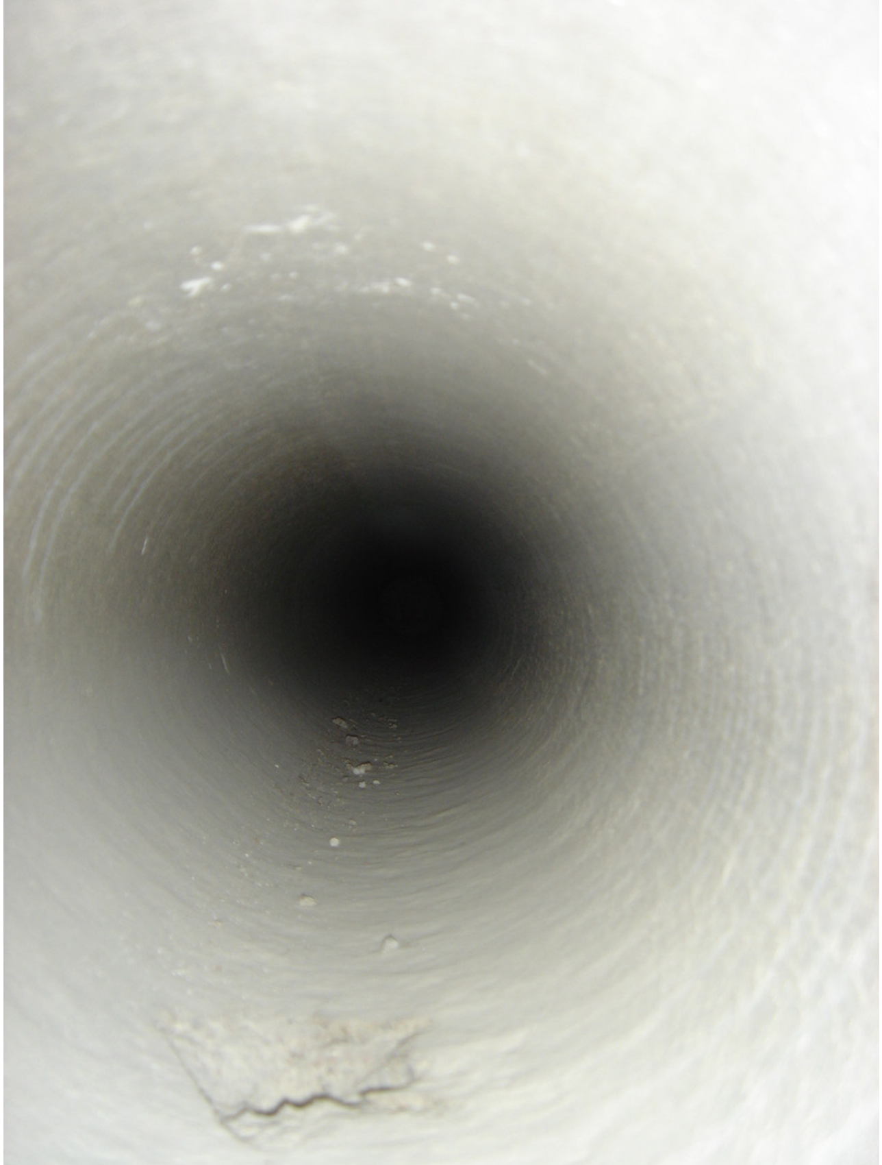
KUVA 11. Onteloiden pinta on paikoin kolhiintunut.
