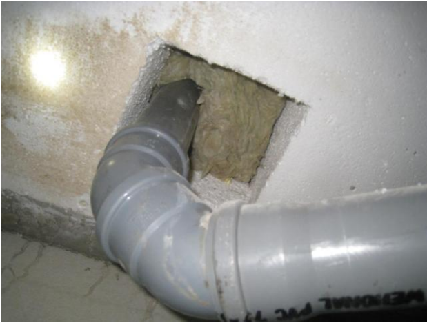
Kuva 41 Tiivistämätön viemäriämpivienti.
