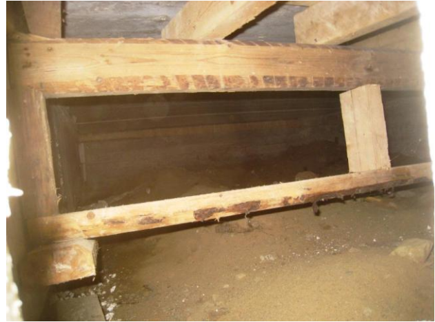
Kuva 15 Kuvan 14 vasemmassa reunassa näkyvän pystysuuntaisen raon kautta kuvattuna. Tilassa puutavaraa.
