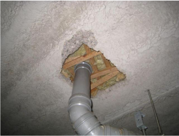
Kuva 20 Tiivistämätön läpivienti.
