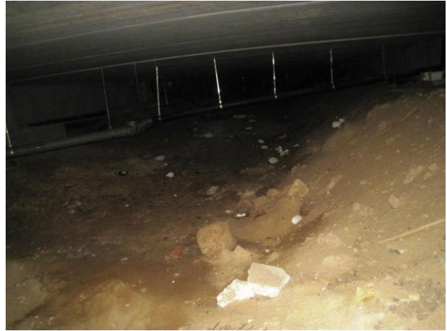
Kuva 8 Maanpinta kosteaa ja pinnalla on mikrobikasvustoa (D-osa).
