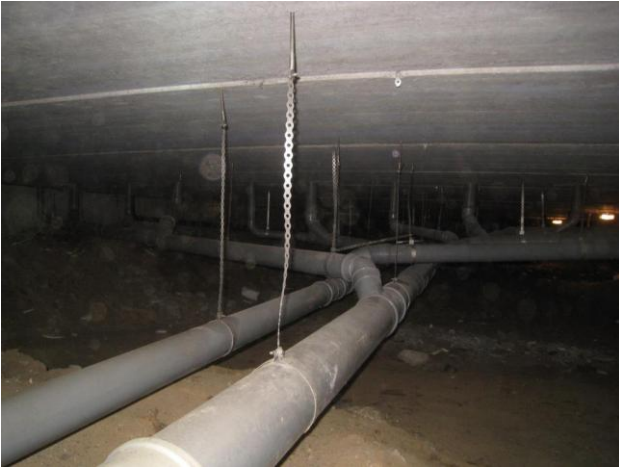
Kuva 18 Viemäriputkia D-osalla.
