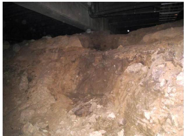
Kuva 6 Maaleikkauksessa savea (A-/ B -osa).
