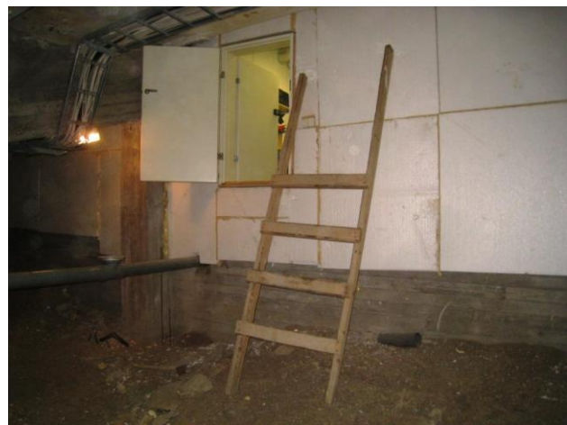
Kuva 30 Tikkaita ei ole tuettu..
