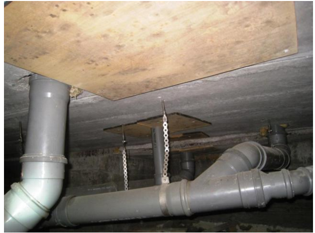
Kuva 21 Valumuottina vaneria.
