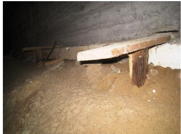
Kuva 17 B-osan porrashuoneen kohdan valun aikaisia alasidepuita.
