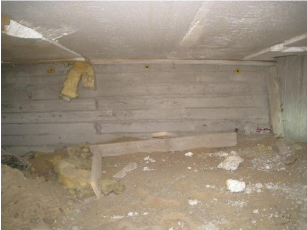
Kuva 38 Kuivaa muottilaudoitusta.
