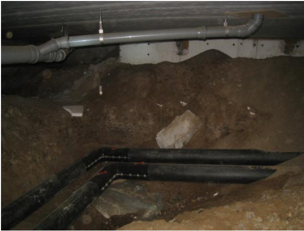
Kuva 9 Kaukolämpöputkikaivanto B-osan päädyssä.
