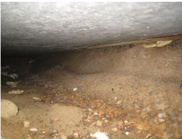
Kuva 26 Näkymä sokkelipalkin alta. Ulkopinnassa polystyreenilevyeristys.
