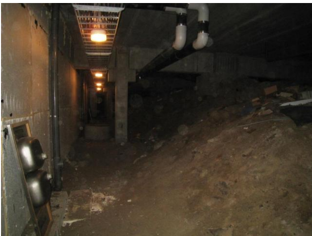
Kuva 5 D-osan alustatilaa käytävän 0038 seinän vierustalla.
