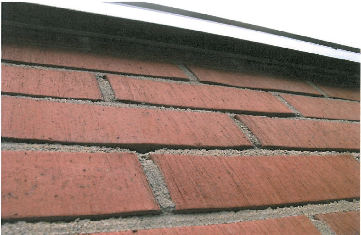
Kuva 6. Tiilisaumapinnat ovat peseytyneitä ja hiekkaisia.
