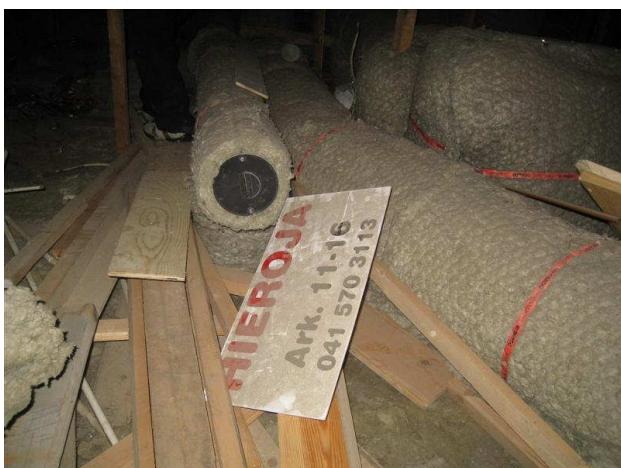
Kuva 15 Rakennustarvikkeita on jäänyt yli.
