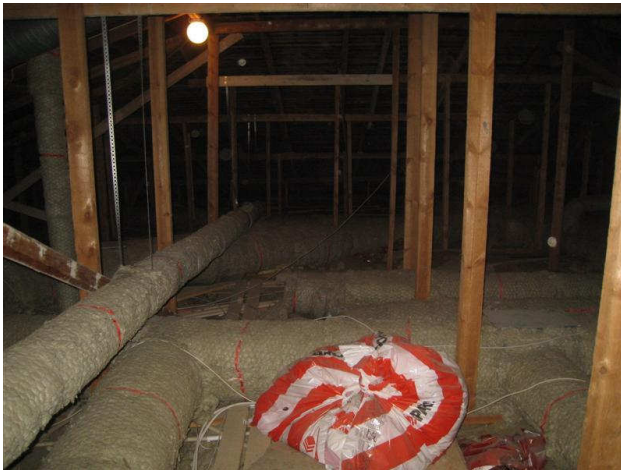
Kuva 19 Yläpohjan asennuksia aulan H10 ja asiakas-wc-pukuh. yläpuolella.
