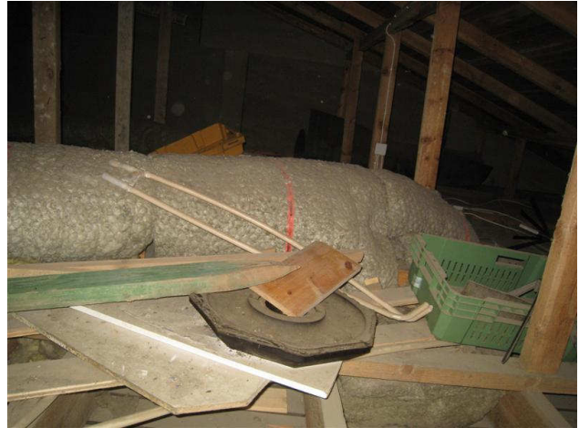
Kuva 14 Sekalaista rojua, jota käytettiin tilapäisenä kulkusiltana.
