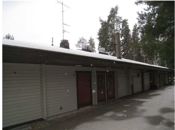
Kuva 6 Vesikatolla on useita IV-puhaltimia. Tilan H11/ lämmitys kohdalla on savupiippu.
