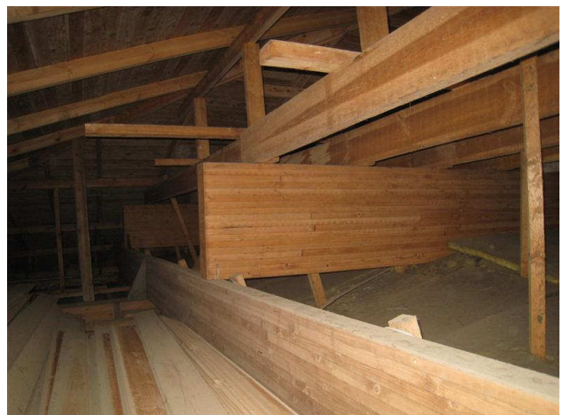
Kuva 16 Vesikaton rakenteena on käytetty myös liimapuupalkkeja.
