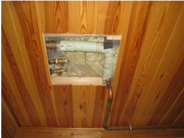
Kuva 1 Korjattu putkivuotokohta vastaanotto H4 katossa.
