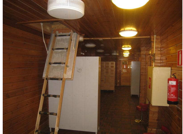
Kuva 2 Näkymä aula-käytävälle H10 ja kulku- reitti yläpohjaonteloon.
