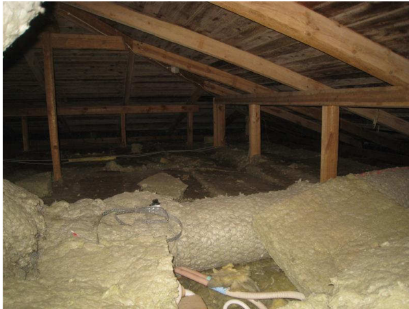
Kuva 23 Asennuksia saunaosaston kulmalla pesuhuoneiden H27 ja H28 yläp.
