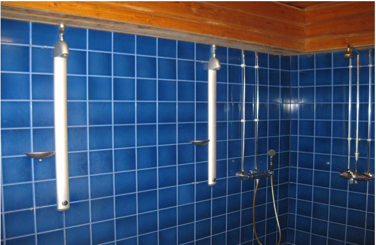
LVI-kuva 12. Yleiskuva saunan uusituista vesikalusteista.
