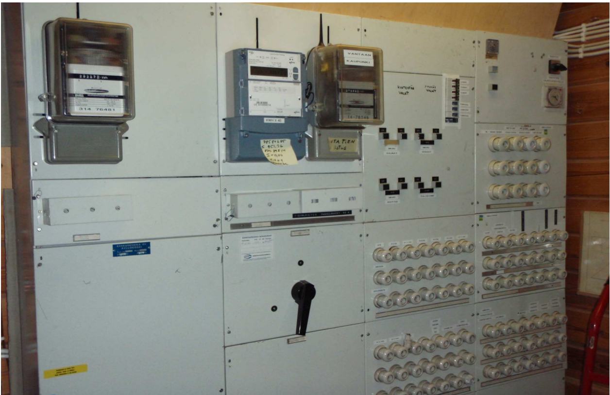
S-kuva 3. Sähköpääkeskus.
