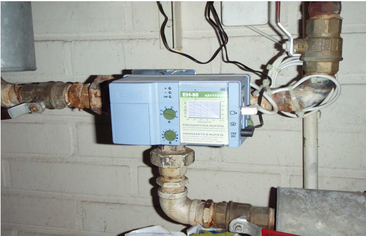
S-kuva 24. Patteriverkoston säädin.
