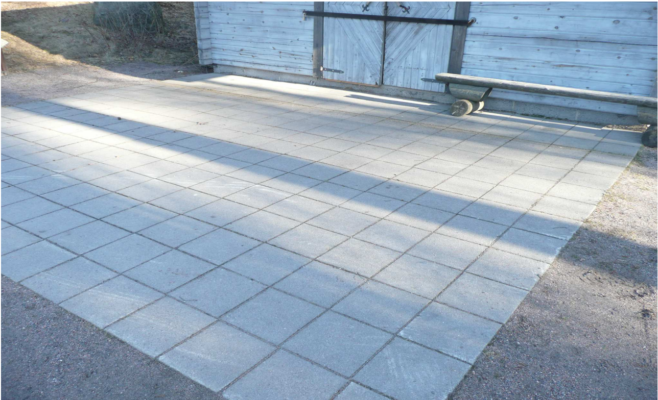
RAK-kuva 1. Muutaman aluerakennuksen edusta on päällystetty betonisilla pihalaatoilla.
