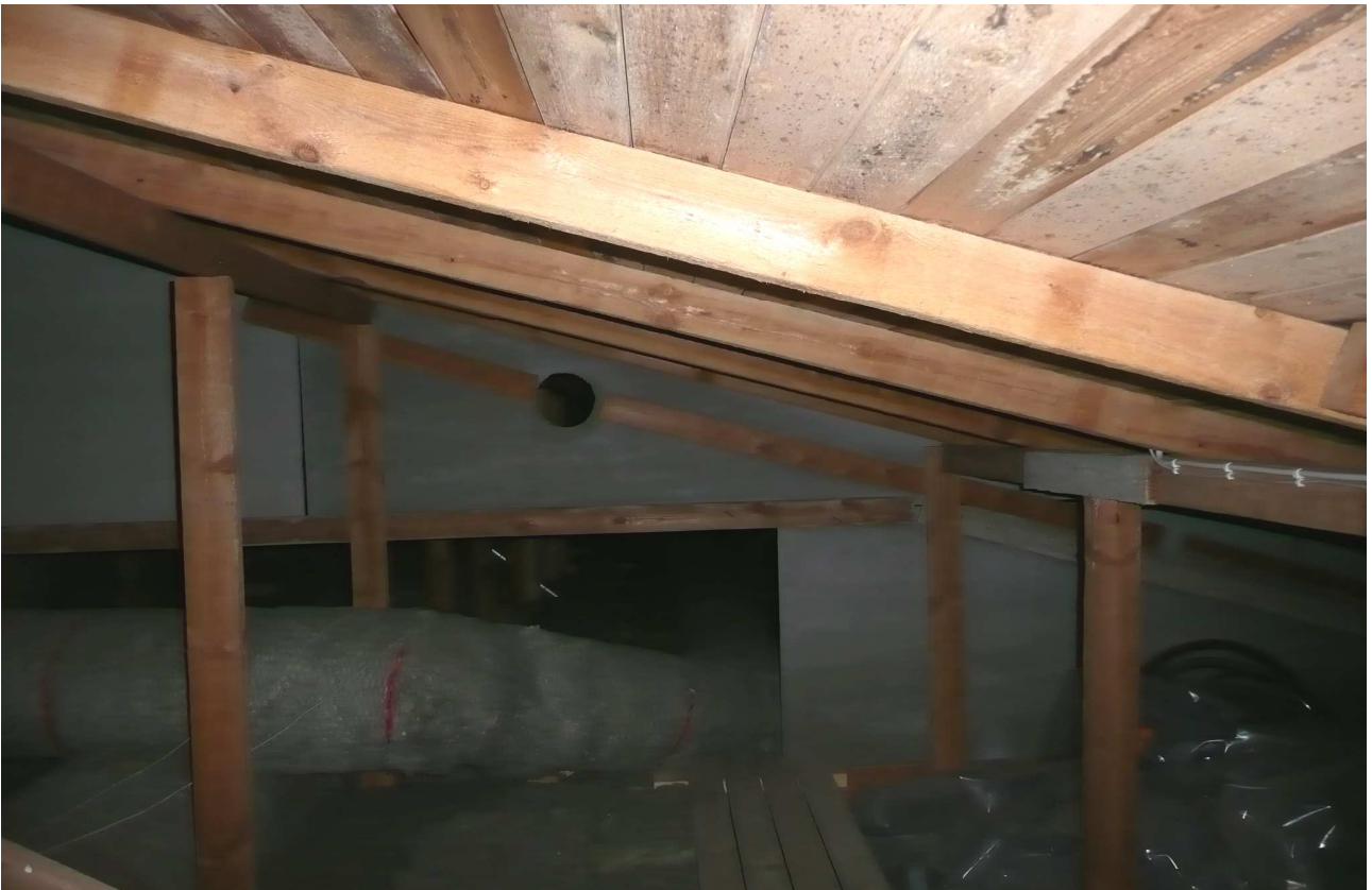
RAK-kuva 6. Yleiskuva yläpohjatilasta.
