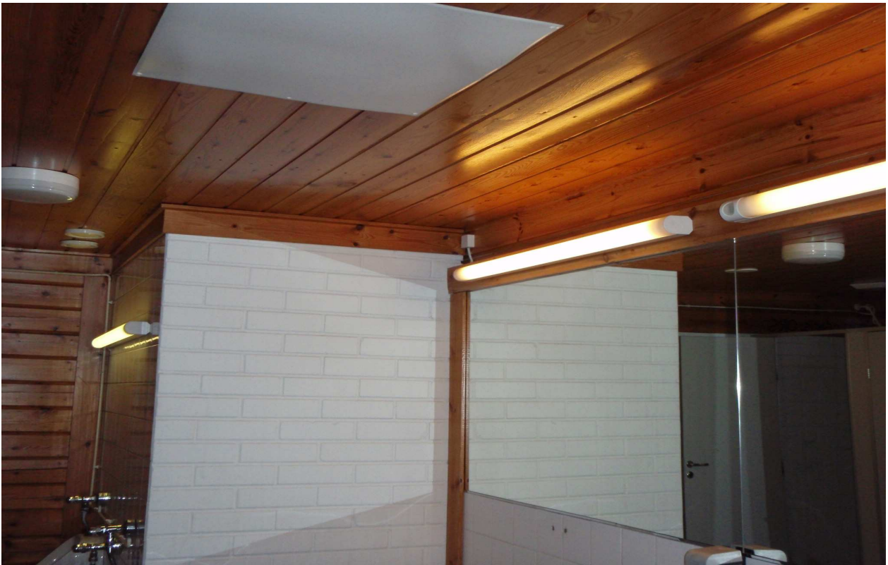
S-kuva 16. Päärakennuksen WC- tilojen valaistus.
