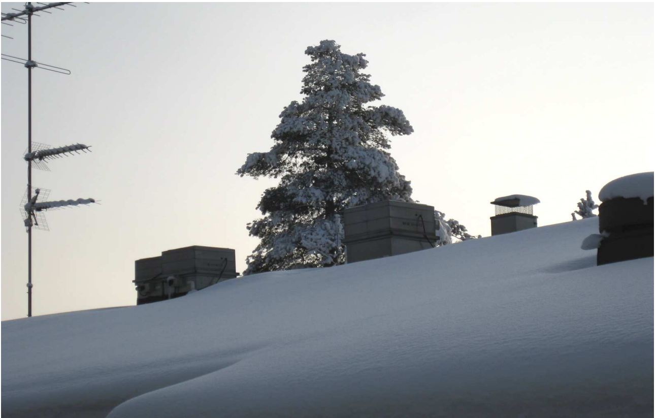
LVI-kuva 20. Yleiskuva huippuimureista.
