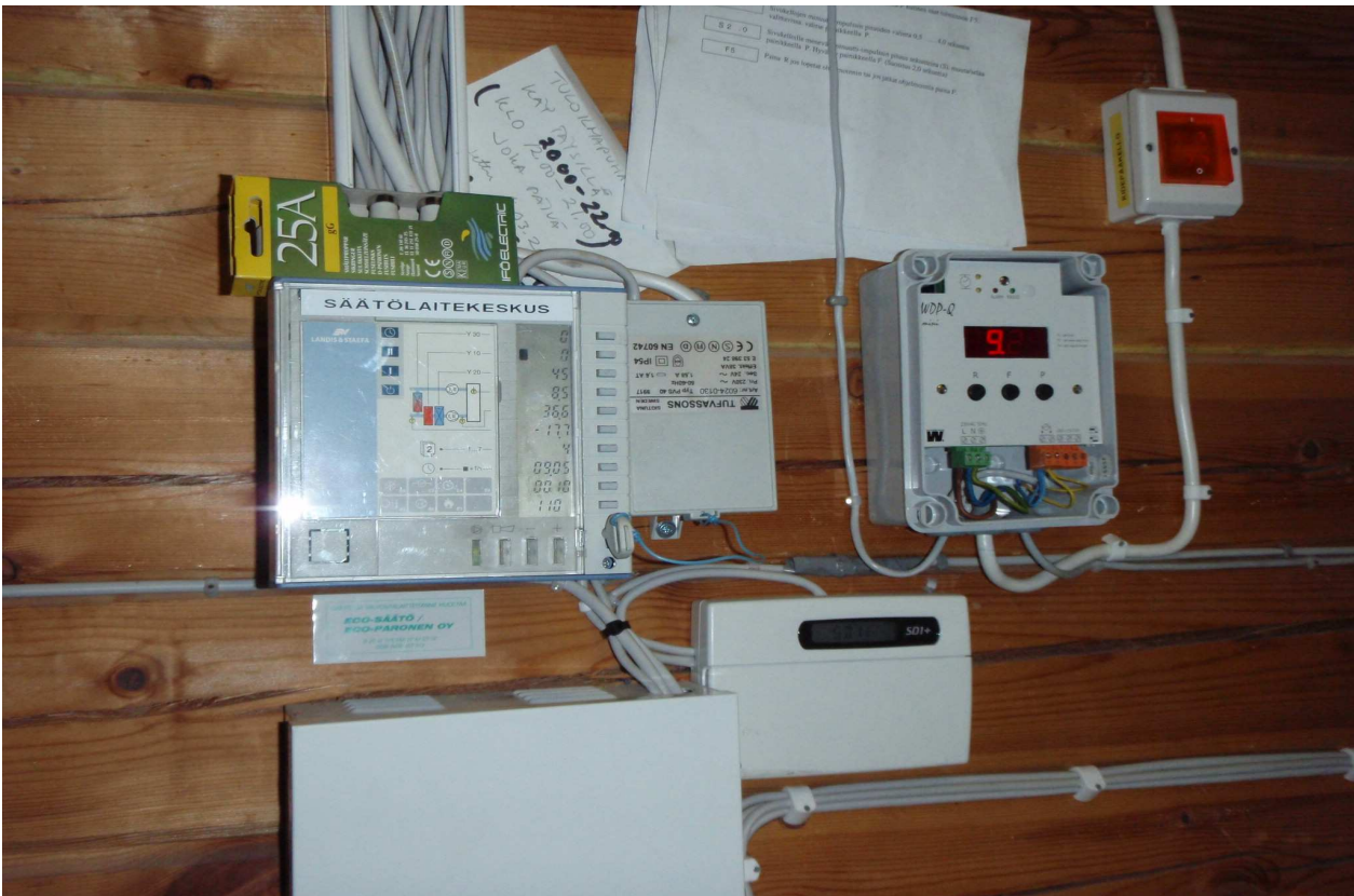
S-kuva 25. IV- koneikon yksikkösäädin ja keskuskello.
