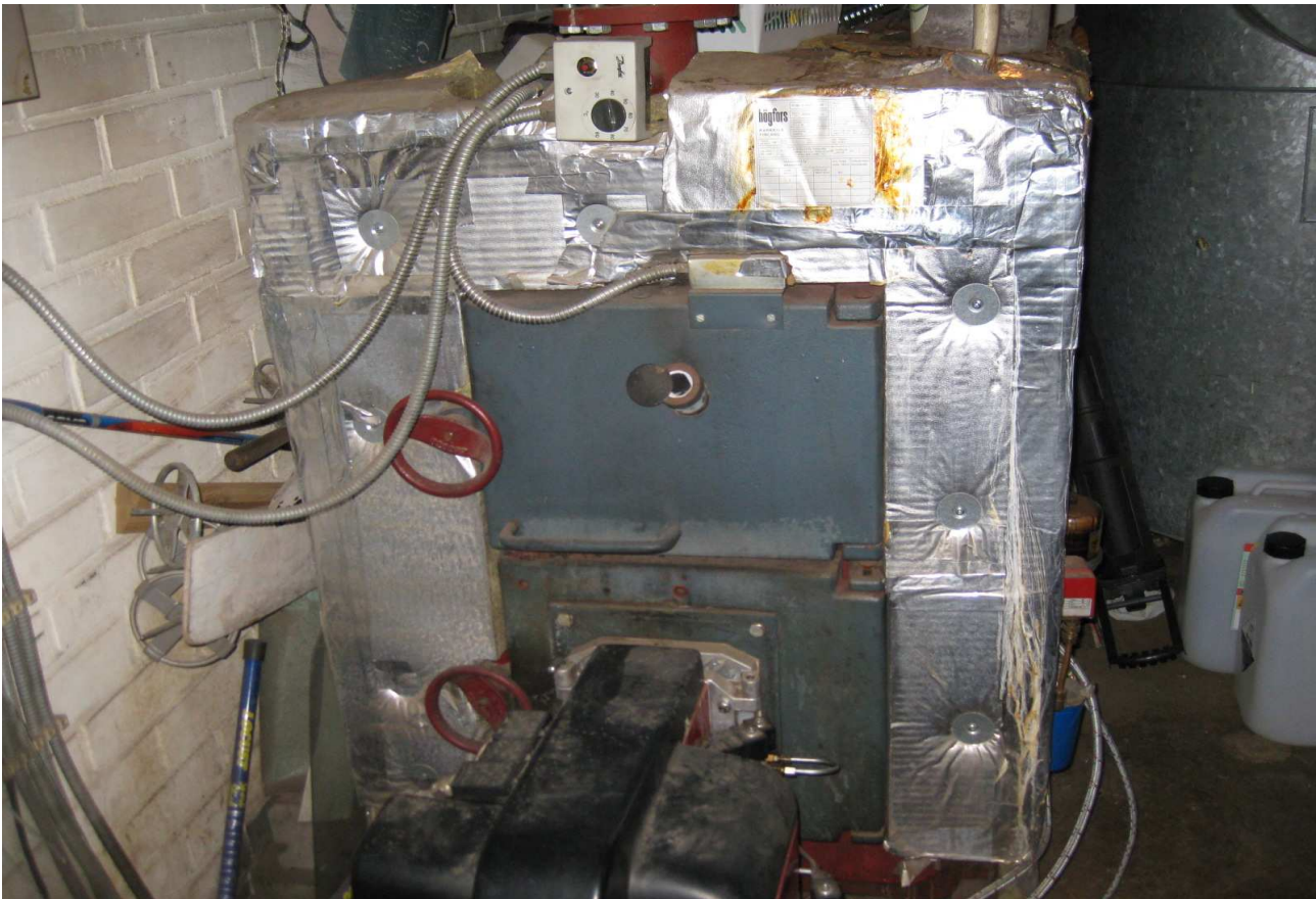
LVI-kuva 1. Yleiskuva pannuhuoneesta.
