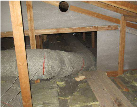
Palo-osastoiva seinä purettu osin
