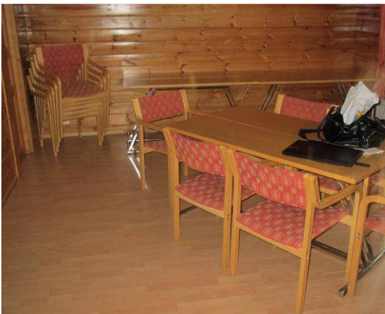
Asuinrakennuksen lattiapinnoitteena on laminaatti
