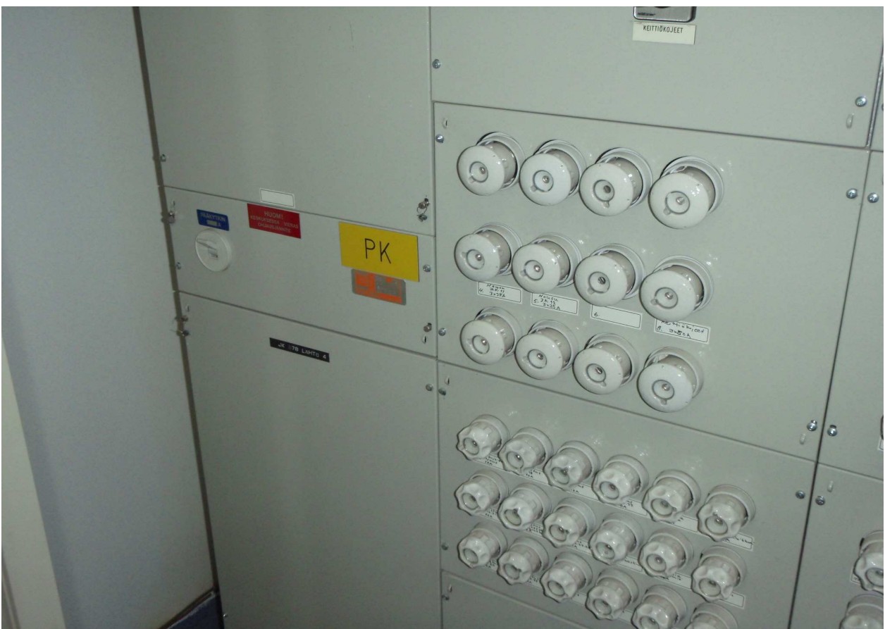
S-kuva 3. Sähköpääkeskus.
