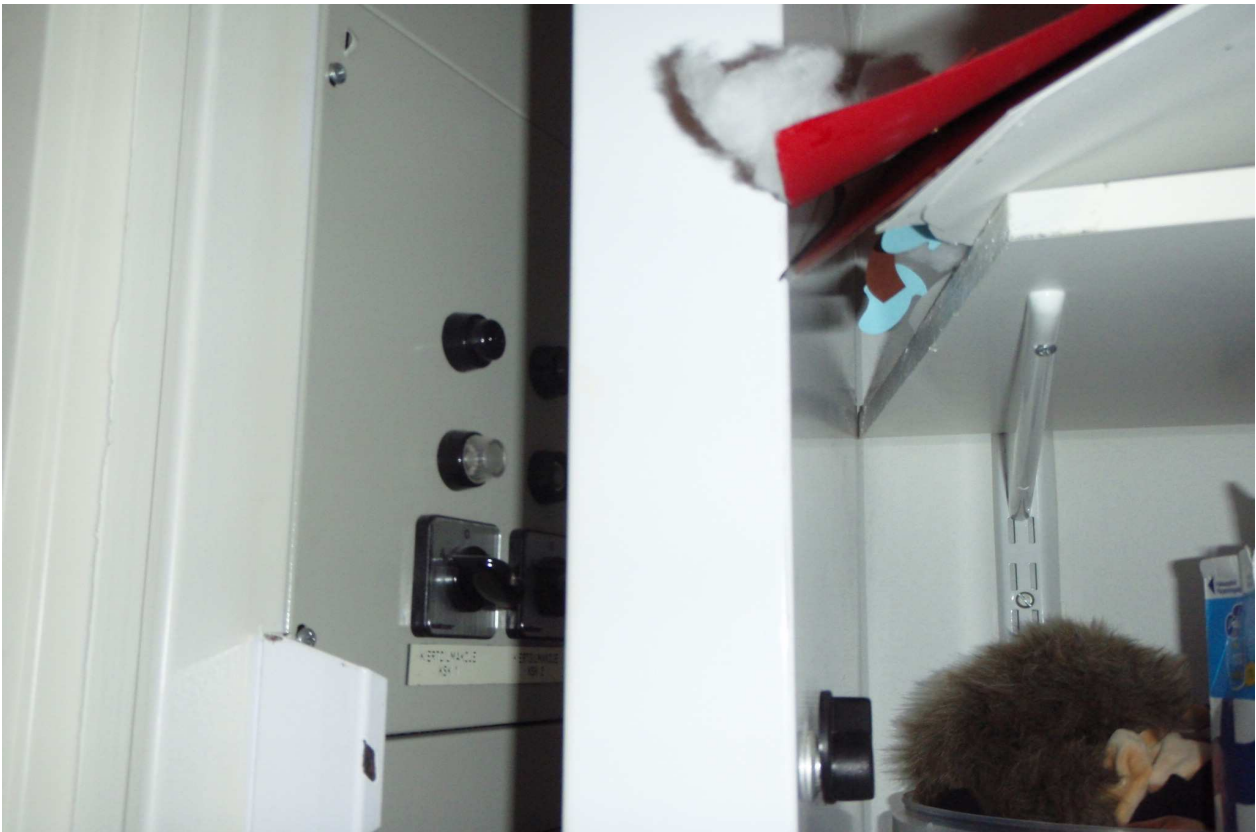
S-kuva 4. JK 1.1 keskus, keskuksella ei ole huoltotilaa.
