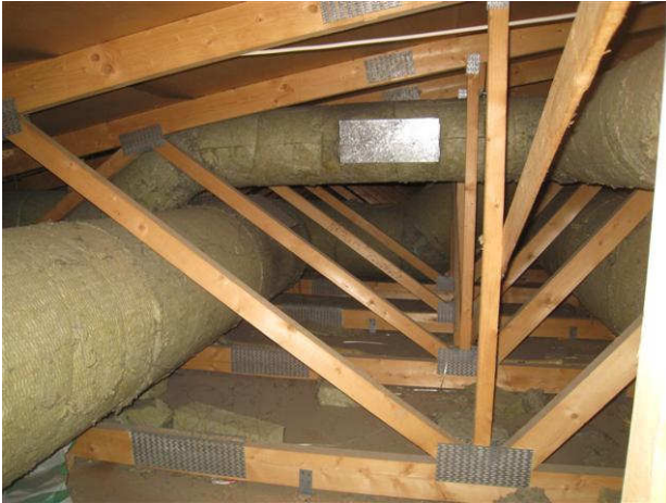
Kuva 19 Yläpohjaontelon IV-asennuksia.
