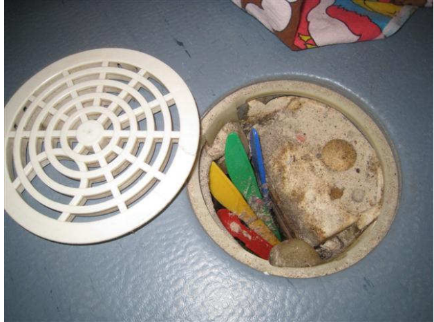
Kuva 28 Haiseva lattiakaivo, johon oli tungettu rojua ja hiekkaa. Liittymä on tiivis.
