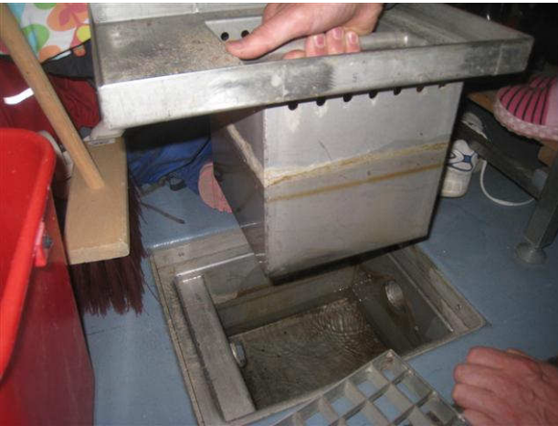
Kuva 27 Märkäeteisen rst-kaivo ja hiekkasiivilä, liittymät vaikuttivat tiiviiltä.
