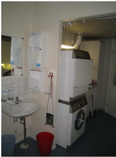
Kuva 39 Henkilökunnan sosiaalitalassa on lat- tiakaivo, mutta tila ei ole varsin. mär- kätilä
