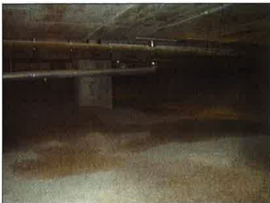
Kuva 9. Yleiskuva kunnostetusta ryömintätilasta.
