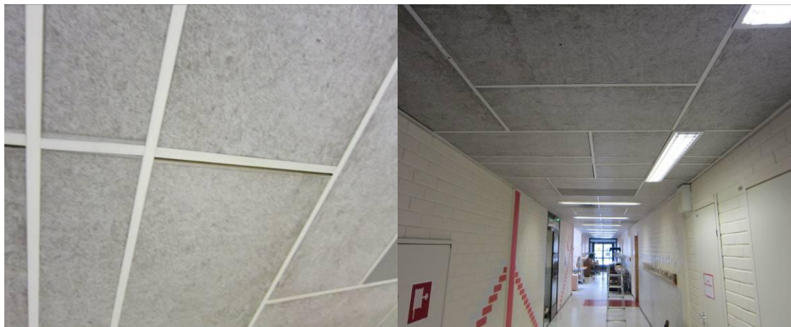
Kuva 23-24. Yleiskuvat koulun käytävästä.
