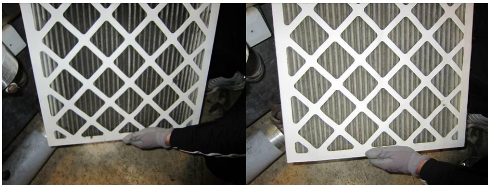
Kuva 9-10. Tuloilmasuodatin on molemmilta puolilta melko likainen.
