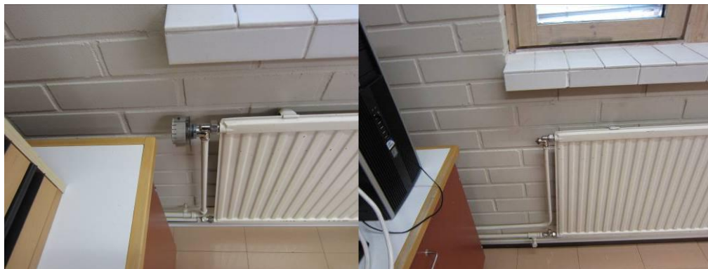
Kuvat 26-27. Tutkimusalueen vesikiertoisten patterien termostaattiset patteriventtiilit olivat alkuperäisiä rakennusvuodelta. Paikoin oli havaittavissa rikkoontuneita patteriventtiileitä.
