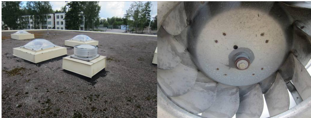
Kuvat 17-18. Yleiskuvat vesikatolta.
