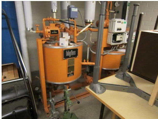
Kuva 25. Kaukolämmön alajakokeskus.
