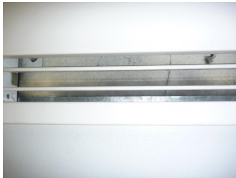
KUVA4: Kuvassa tuloilma säleikössä käytettyä villaeristettä.
