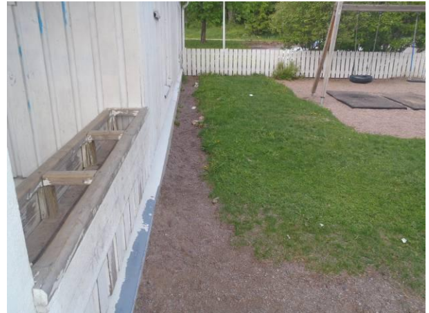
Kuva 7. Kohdassa P9 sorakaista viettä rakennuksen suuntaisesti keräten veden rakennuksen viereen. Pintamaa on tasainen.
