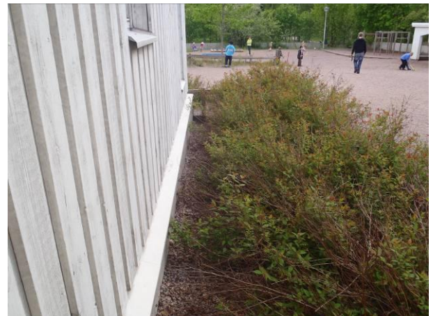
Kuva 4. Rakennuksen vierustalla on kasvillisuutta.
