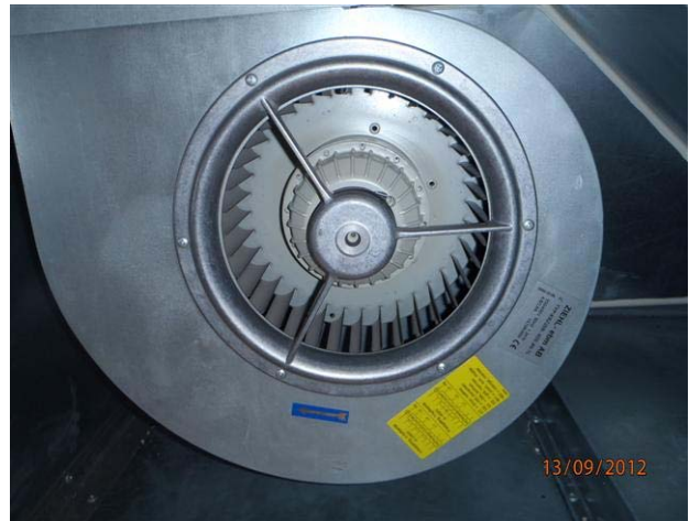
kuva 1 Ilmanvaihtokonepaketti TK03 TF01/PF01 on hyvässä kunnossa. kuva 2 Ilmanvaihtokoneen TK01 PF01 puhallinosa on puhdas.
