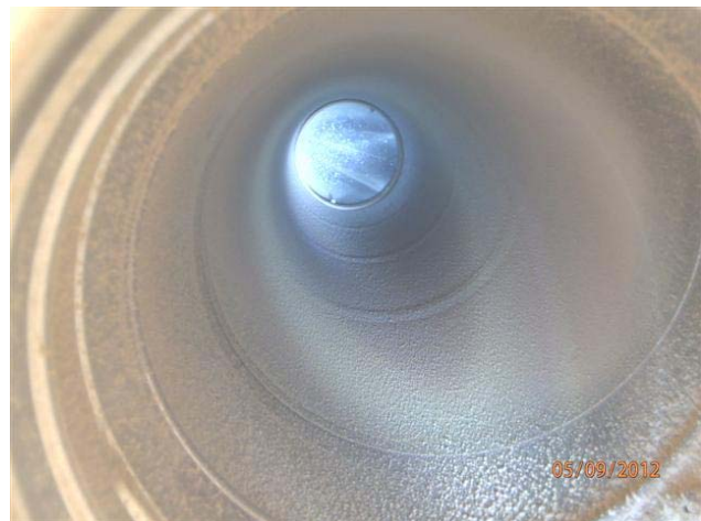
kuva 3 Huippuimurin TK05 PF03 puhallinosa on likainen. kuva 4 Poistokanava (ph / wc 104) on puhdistuksen tarpeessa.
