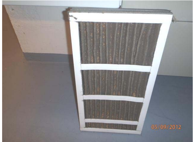
kuva 5 Kellaria palvelevan tuloilmakoneen raitisilmasuodatin. kuva 6 Alustatilan tuloilmakoneen raitisilmasuodatin on lähes tukossa.
