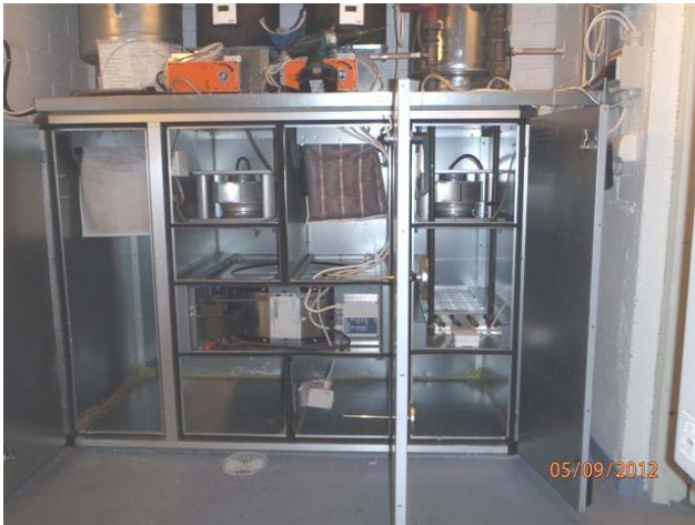
kuva 1 Ilmanvaihtokonepaketti TK03 TF01/PF01 on hyvässä kunnossa. kuva 2 Ilmanvaihtokoneen TK01 PF01 puhallinosa on puhdas.
