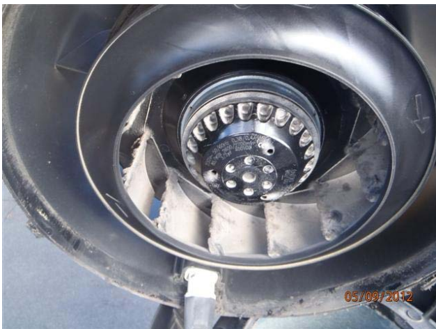
kuva 3 Huippuimurin TK05 PF03 puhallinosa on likainen. kuva 4 Poistokanava (ph / wc 104) on puhdistuksen tarpeessa.
