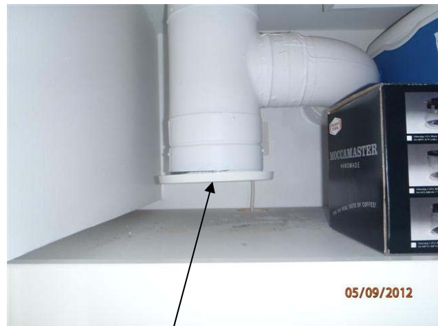
kuva 7 Tuloilman pääte-elimet. Poistoilmaventtiilit. Tuloilman puhallussuunta on oltava poispäin poistoilmaventtiileistä. kuva 8 Poistoilmaventtiili on liian lähellä rakenteita.
