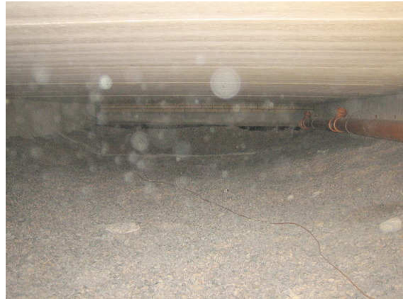
Kuva 4 Kadun puoleinen alustatila/ lohko. Taustalla alkuperäisosan ulkoseinää/ sokkeli-rakennetta.
