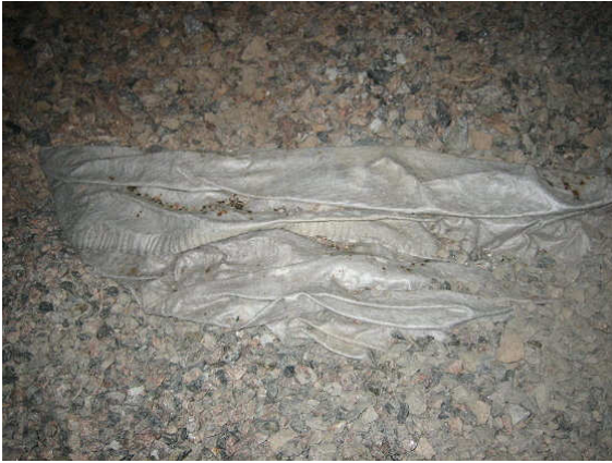
Kuva 9 Noin 100 mm vahvuisen sepelikerroksen alla on suodatinkangas.
