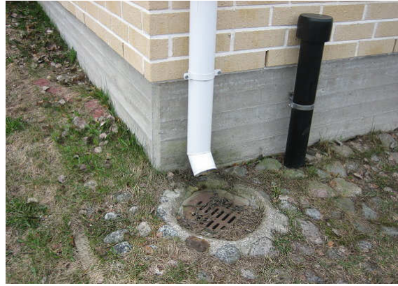
Kuva 2 Kattovedet johdetaan syöksytorvien kautta sadevesikaivoihin.
