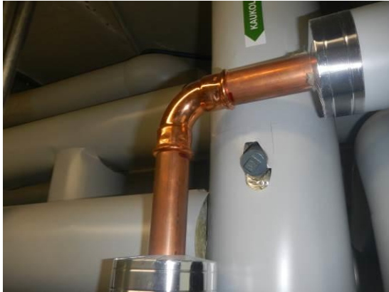
Kuva 12. Uusittu putkiosuus lämmönjako- huoneessa, kiertovesijohto.
