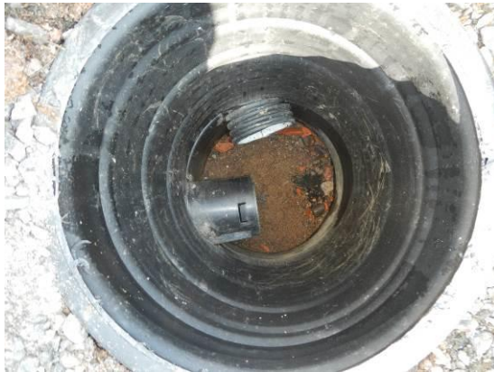
Kuva 26. Uusittu salaojakaivo, sok2.
