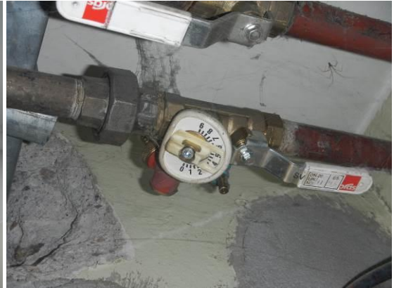
Kuva 5. Näyttötaulukien mukaan lämpöjoh- toverkoston virtaamat on säädetty.
