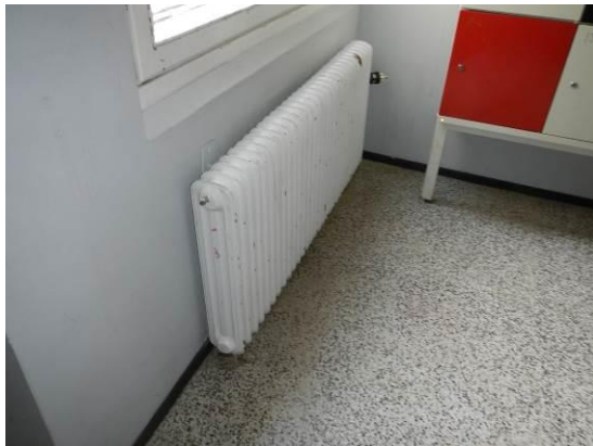
Kuva 6. Vanha peltipatteri.
