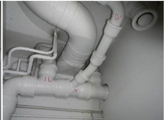
Kuva 19. Vanhoja valurautaviemäreitä kellarikerroksen wc-tiloissa.
