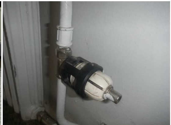
Kuva 7. Vanha patteriventtiili, merkki Oras.
