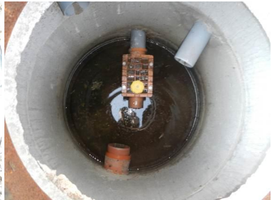
Kuva 27. Uusittu padotusventtiili, svtk1.
