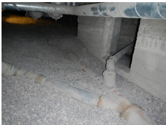
Kuva 20. Pohjarunkoviemäri on osittain näkyvissä ryömintätilassa.
