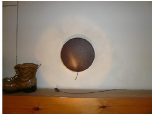
Kuva 20. Raitisilmaventtiili sisäpuolelta
