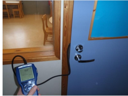
Kuva 14. Huonetilojen välinen paine-eromittaus
