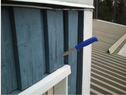
Kuva 5. Ulkoverhouslaudassa lahoa.
