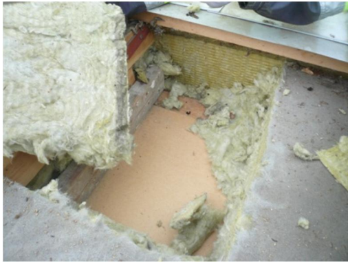
Kuva 7. Yläpohjan rakenneavaus
