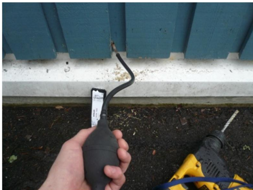
Kuva 17. Merkkisavukoe leikkihuoneen kohdalla
