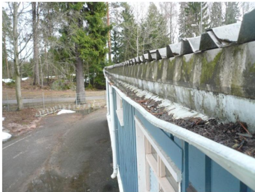
Kuva 9. Rästääjän rakenne ja vesikouru
