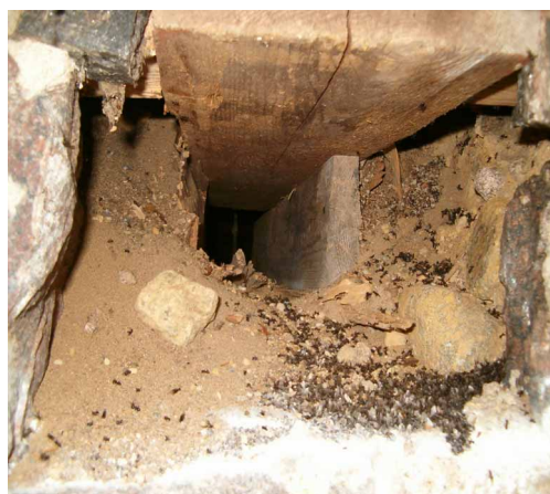
Kuva 9: Muurahaisia alapohjarakenteissa (4.2).
