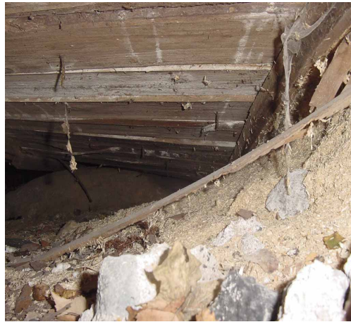
Kuva 7: Lahonneita alapohjarakenteita (4.2).
