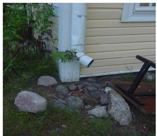
Kuva 10: Syöksytorvi seinän vieressä (4.3).
