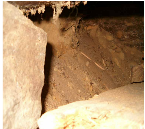
Kuva 8: Lahonneita alapohjarakenteita (4.2).
