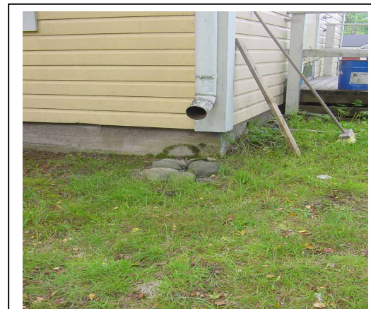
Kuva 4: Laajennusosan betonisokkeli (4.2).
