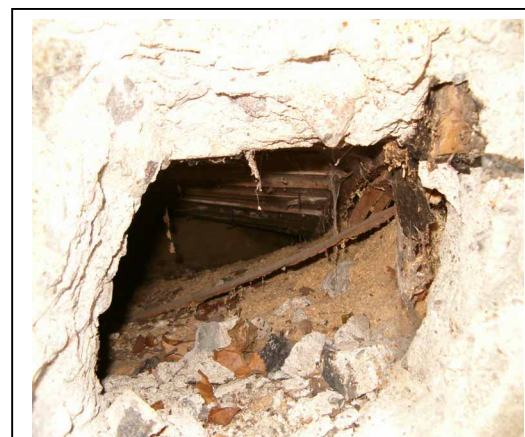
Kuva 6: Lahonneita alapohja-rakenteita (4.2).
