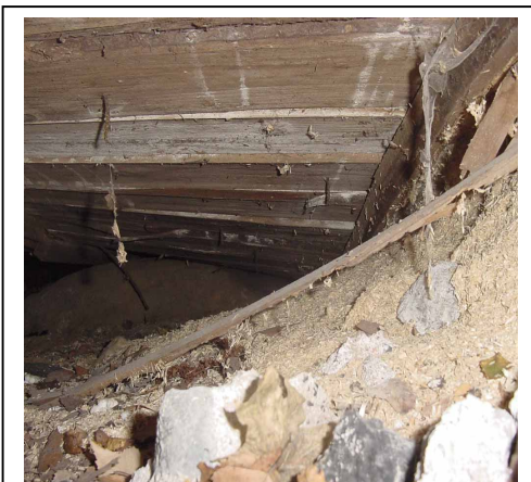
Kuva 11: Lahonneita alapohjarakenteita (3.2.1).
