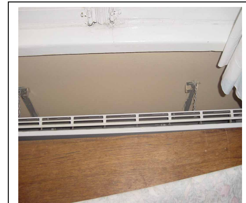
Kuva 40: Huoltoketjujen varaan laskettu lämmitin (5.4.2).
