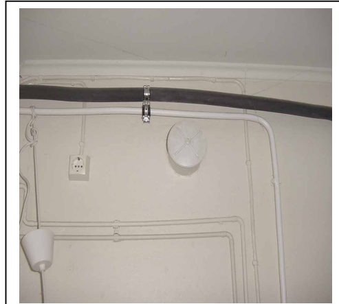
Kuva 26: Kylmävesijohdon kondenssieristystä (4.2.6).
