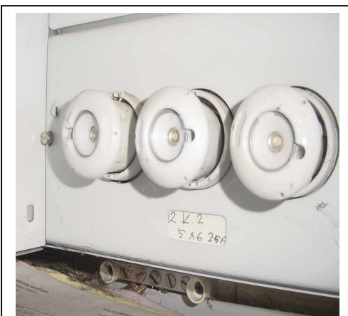
Kuva 35: Päämaadoituskisko MK/PK: n alla (5.3.1).
