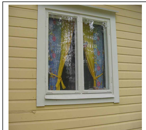
Kuva 12: Ulkoverhousta ja ikkuna (3.2.3).
