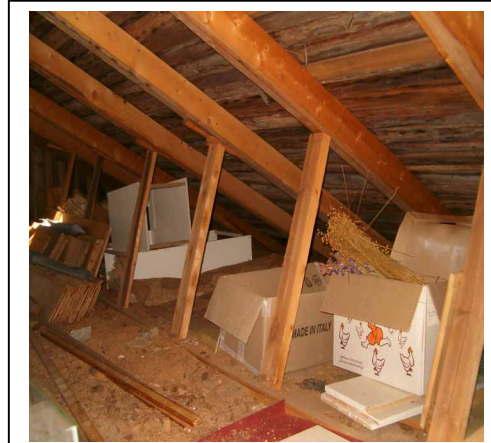
Kuva 14: Kattotuolit ja yläpohjan hiekkatäyte (3.2.4).
