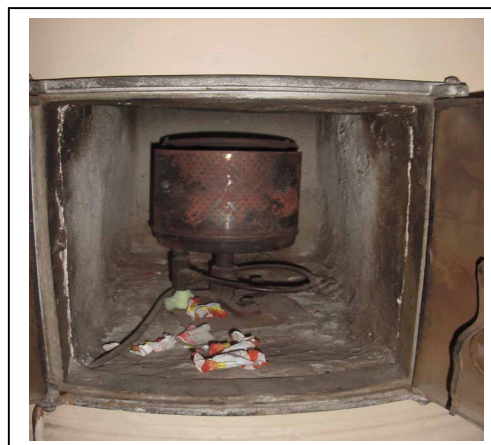
Kuva 18: Pystyuuniin asennettu kaasupoltin (4.1.1).
