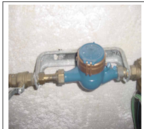
Kuva 21: Vesimittari (4.2.2).
