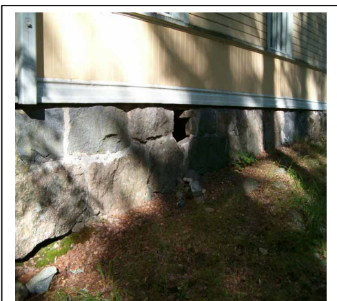
Kuva 5: Maanvarainen kivisokkeli (3.2.1).
