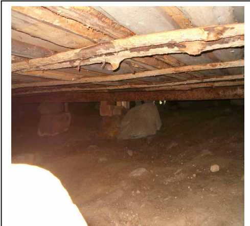
Kuva 7: Puurakenteista alapohjaa (3.2.1).
