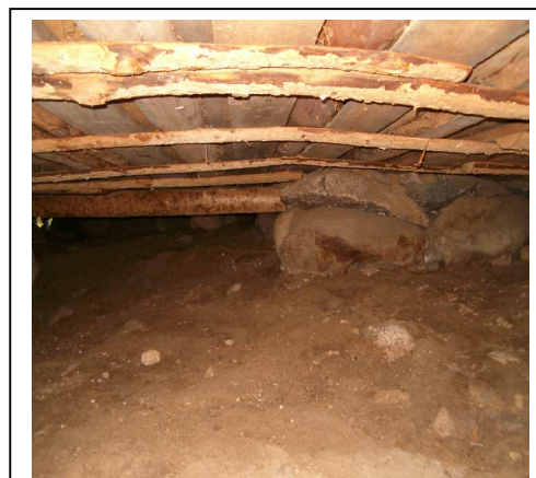
Kuva 6: Puurakenteista alapohjaa (3.2.1).
