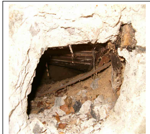
Kuva 10: Lahonneita alapohjarakenteita (3.2.1).
