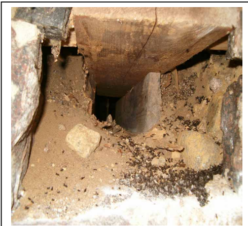
Kuva 9: Muurahaisia alapohjarakenteissa (3.2.1).
