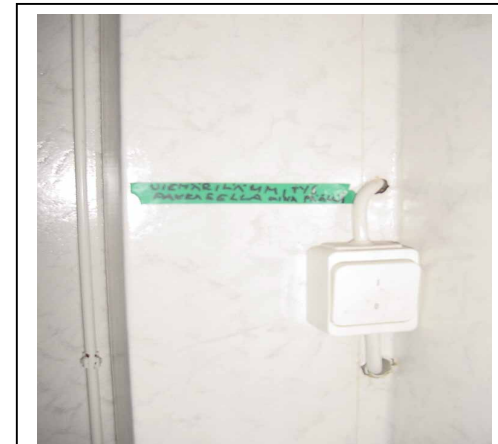
Kuva 46: Sulanapitolämmityksen kytkin (5.4.3).
