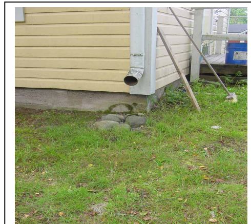
Kuva 4: Laajennusosan betonisokkeli (3.2.1).
