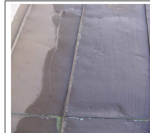
Kuva 16: Hilseilevää kattomaalipintaa (3.2.4).
