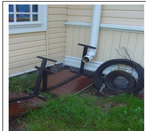
Kuva 2: Syöksytorvi seinän vieressä (3.1.1).
