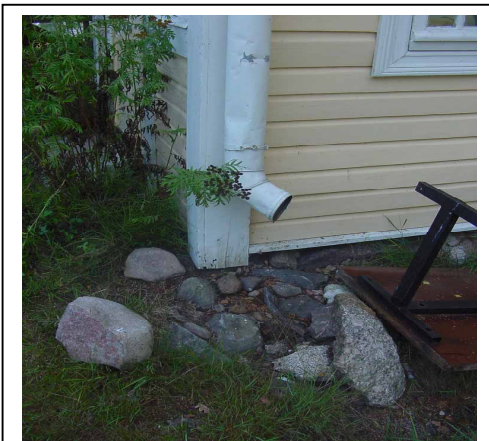
Kuva 1: Syöksytorvi seinän vieressä (3.1.1).
