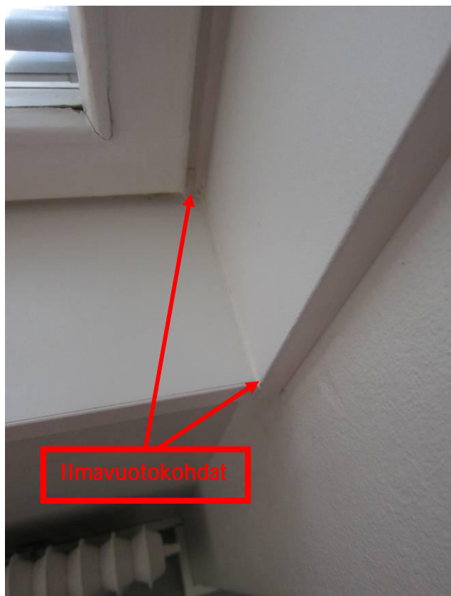
Kuva 1. Ikkunaliittymästä havaittiin ilmavuotoa nuolien osoittamista paikoista.
