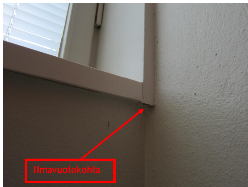
Kuva 3. Ikkunapenkin alapuolelta havaittiin ilmavuotoa.
