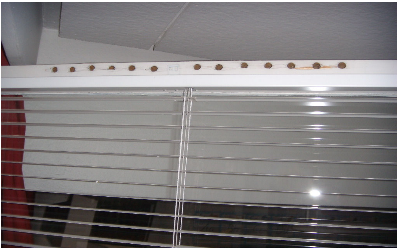
KUVA 12. Korvausilmaventtiin reiät.
