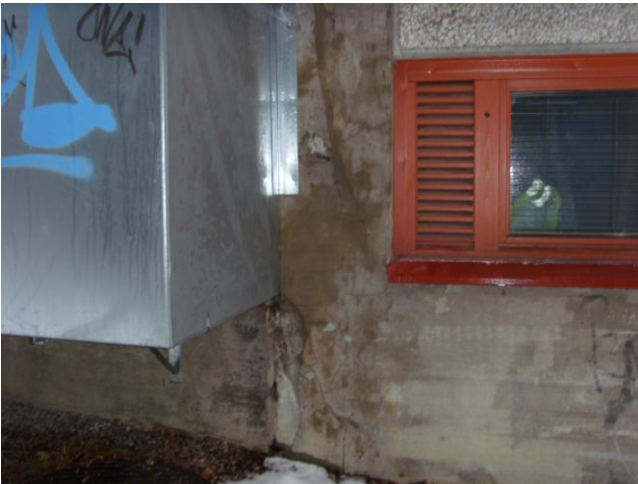
Kuva 7. Sokkelin paikkaukset ovat rapautuneet
