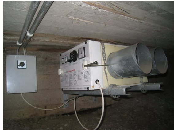
Kuva 10 Paine-erolla toimiva tuloilmalämmitin.
