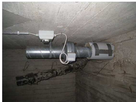
Kuva 12 Poistoputkessa kanavapuhallin.
