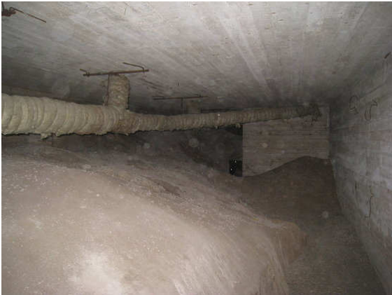
Kuva 3 Alustatilassa kalliota ja täyttönä hienoainesta sisältävää sepeliä.
