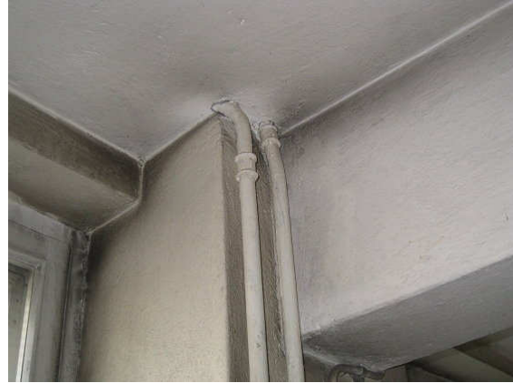
Kuva 6 Tyypillinen putkiläpivienti, jossa ei havaittu ilmavuotoa.
