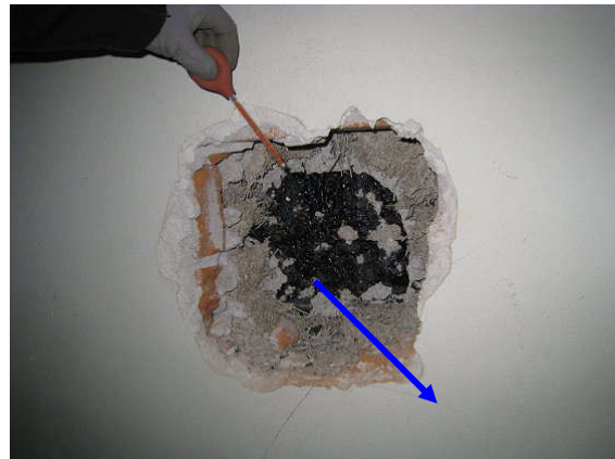
Kuva 8 Tilassa 001 avattu sisäverhousmuurausta. Ilmavirtaus on huoneeseen päin.
