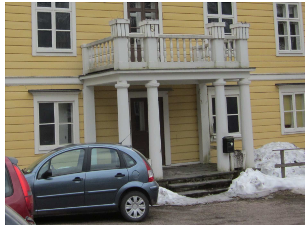
Kuvaa rakennuksen parvekkeesta
