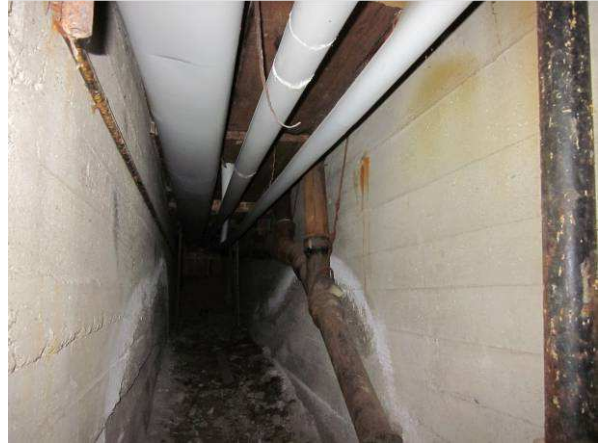
Kuvaa kellarikerroksen betonirakenteista
