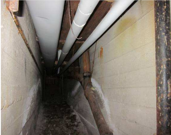
Vanhoja kokoojaviemäreitä ja putkieristyksiä
