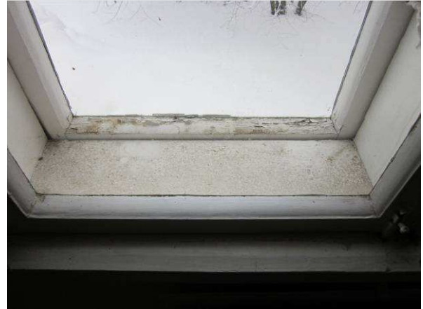
Rakennuksen ikkunat ovat kaksilehtisiä, kaksilasisia puuikkunoita
