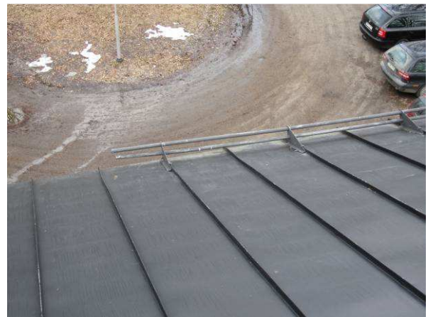
Pääsisäänkäynnin yläpuolella lumieste on taipunut lumen vaikutuksesta
