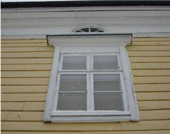
Yleiskuvaa rakennuksen ikkunasta
