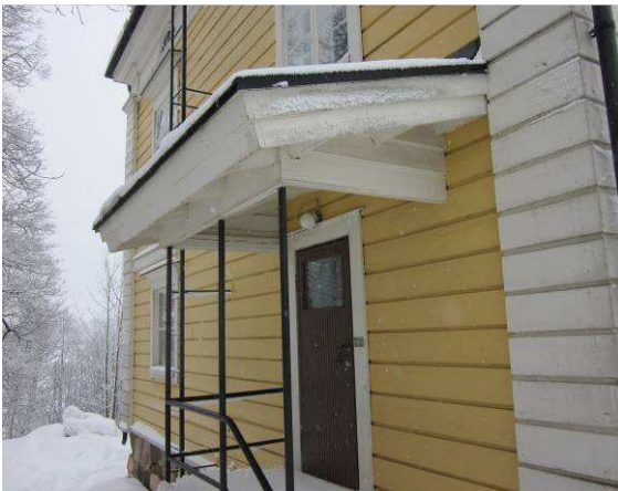
Kuvaa puurakenteisista sisääntulolipasta
