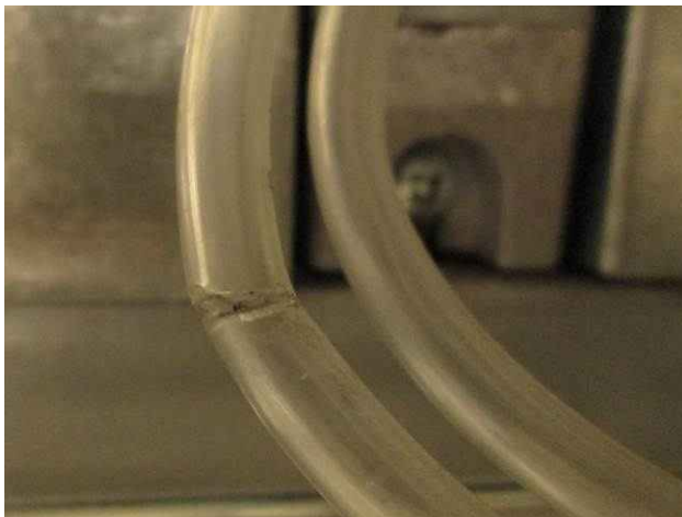
Kuva 17. Letku katkennut TK15:n tulosuodattimen paine-erolähtetimestä.
