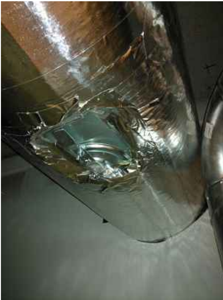
Kuva 6. Silmätoimenpidehuoneessa 235 olevaan tuloilmakanavaan on asennettu sulkupelti säätöpellin sijaan.
