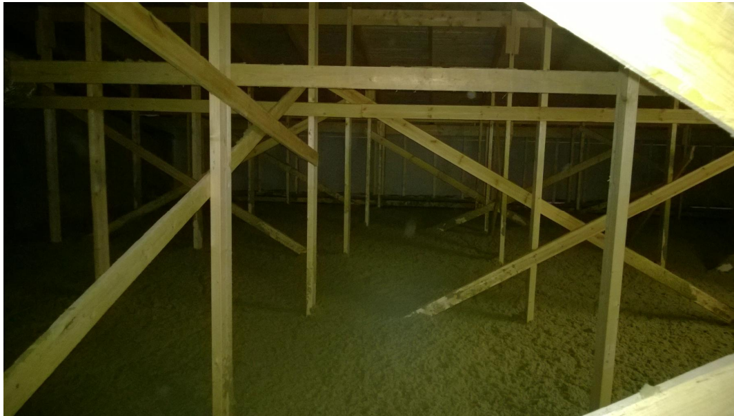
Kuva 44. Ullakkotilan puurakenteet olivat hyvässä kunnossa pois lukien paikalliset kosteusjäljet kuvissa 42–43.
