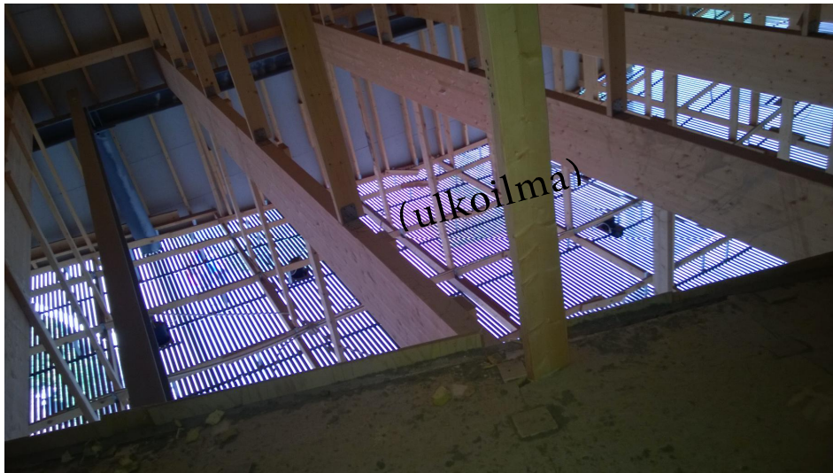
Kuva 12. Näkymä tilojen 2.111 ja 2.112 yläpuolisessa yläpohjarakenteessa.
