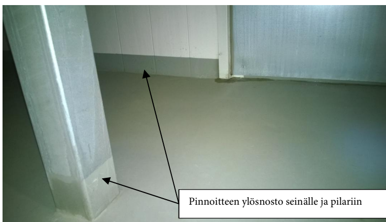
Kuva 46. Raitisilmakammion lattia on pinnoitettu suunnitelmien mukaisesti polyuretaanielastomeerilla.
