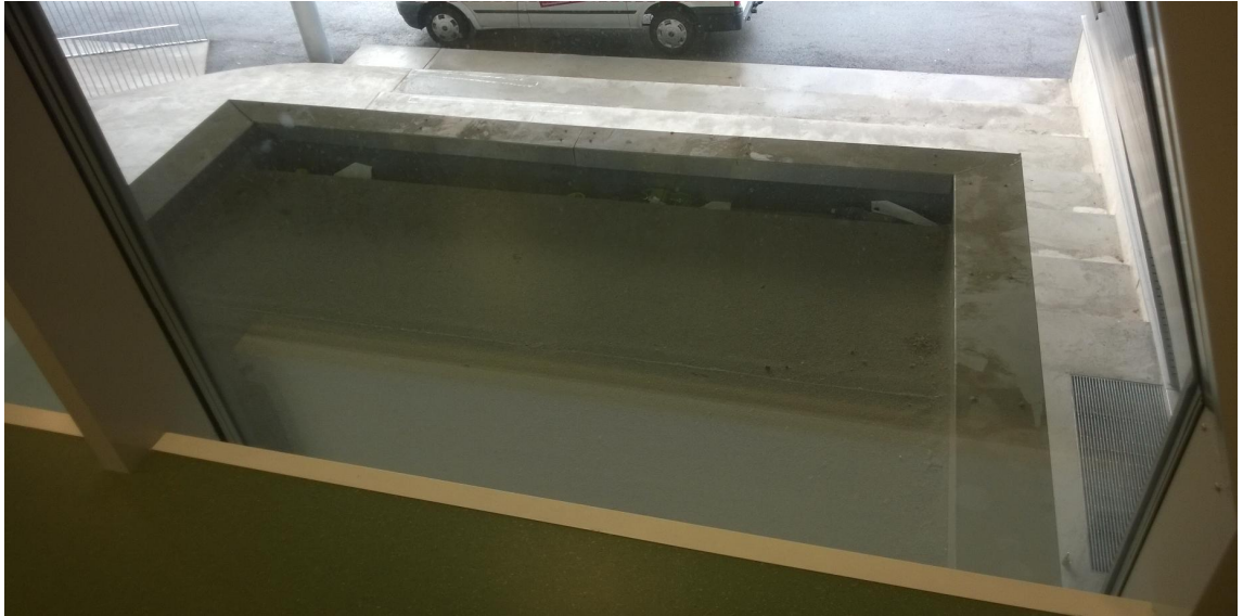
Kuva 45. Pääovien yläpuolinen katos.
