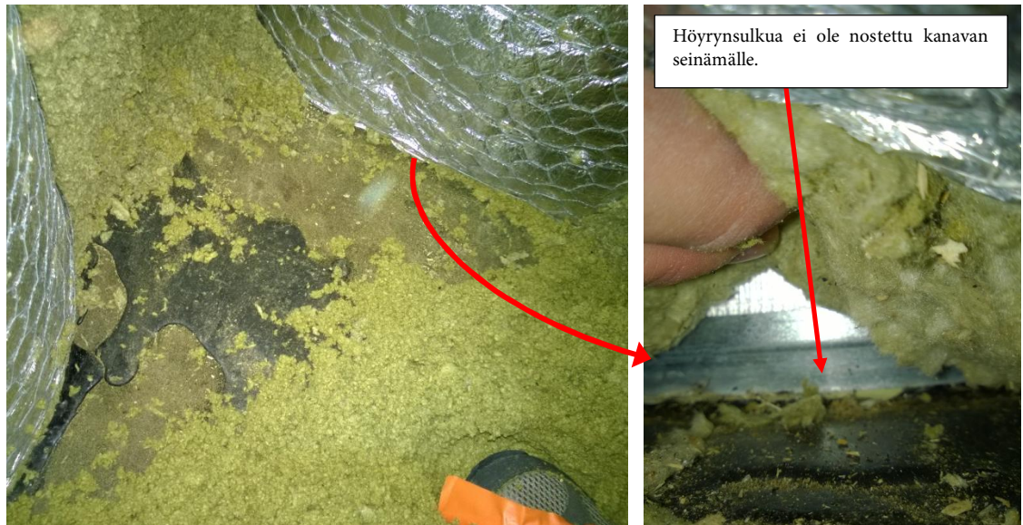
Kuvat 22–23. Tilan 2.112 yläpuolella yläpohjarakenteen puhallusvilla lapioitiin pois ilmanvaihtokanavan ympäriltä.
