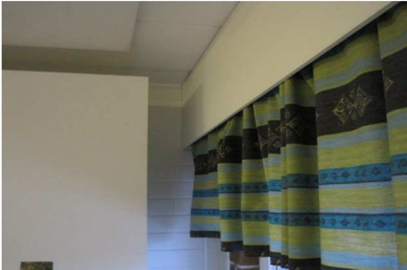
huone 104 seinä ja kattorakenteet mittauksin kuvia
