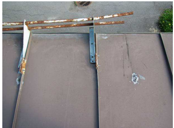
Vanhat lumiasteiden kiinnityskohdat ovat olleet auki jo pidemmän aikaa
