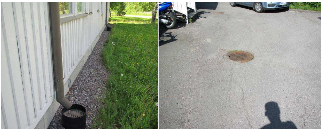
Sokkelin vierustalla on asianmukainen sorastus ja kattovedet menevät rännikaivoihin
