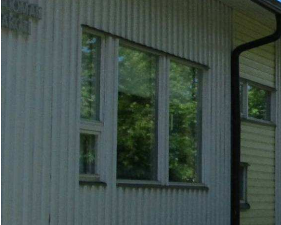
Rakennuksen ikkunat ovat alkuperäisiä puuikkunoita
