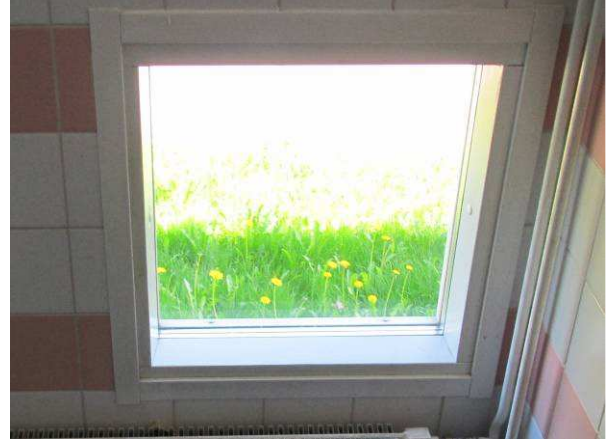
Kuvaa wc-tilan ikkunasta sisäpuolelta
