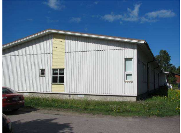
Yläpohjatiloihin on kulku rakennuksen päädystä kulkuluukun kautta
