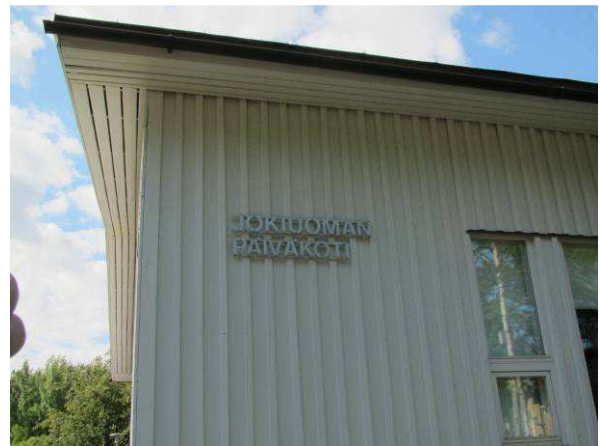
Julkisivuverhoukset ovat tyydyttävässä kunnossa
