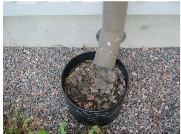
Sadevesisuppilot tulee puhdistaa säännöllisesti.
