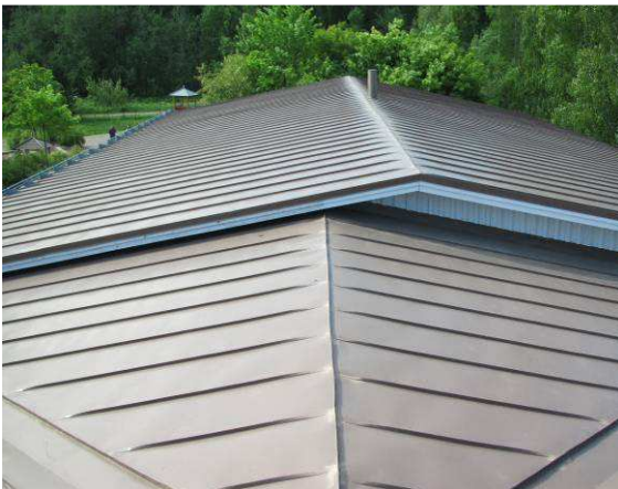
Yleiskuvaa vesikatolta, katemateriaali on konesaumattu peltikate
