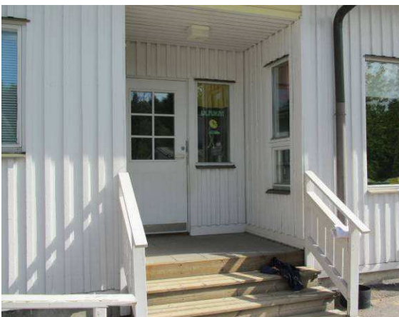
Ulko-ovet ovat yksilehtisiä puuovia
