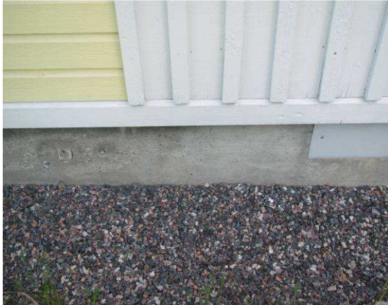
Betonisokkelit ovat tyydyttävässä kunnossa
