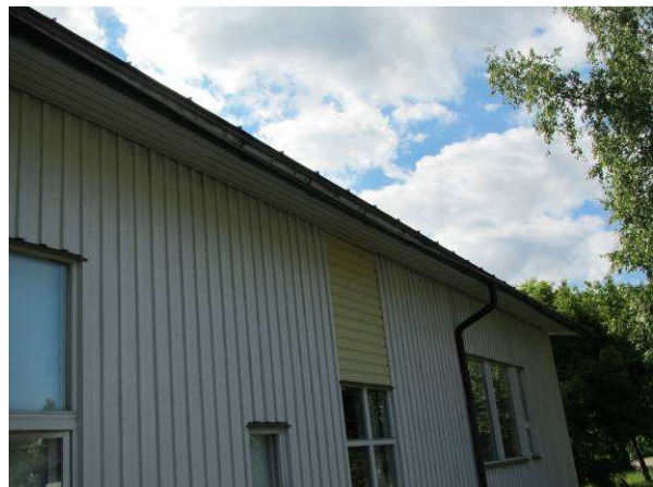
Räystäskourun kannakkeet ovat antaneet periksi
