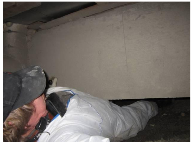
Kuva 14 Palkkien ali mentiin kaivautuen.
