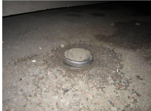
Kuva 4 Salaojan tarkastusputken kansi.
