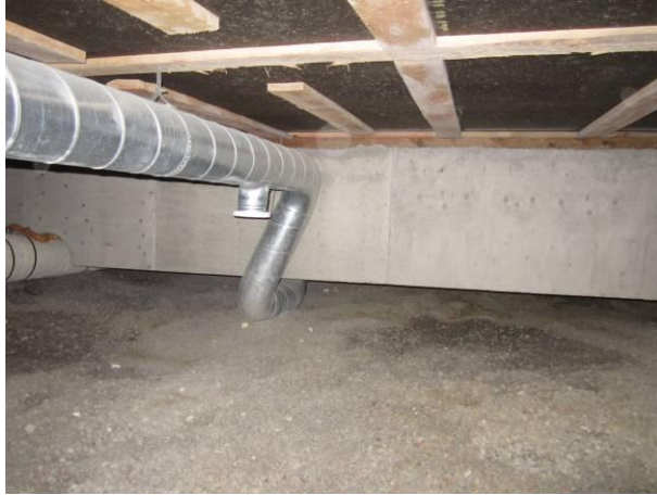
Kuva 7 Poistoilmakanava peruspalkin ali.
