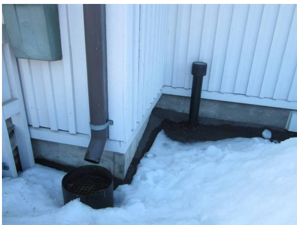
Kuva 5 Muovinen korvausilmaputki ja rännikaivo.
