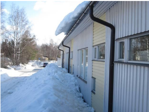
Kuva 1 Vihertien puoleinen pohjoissivu.
