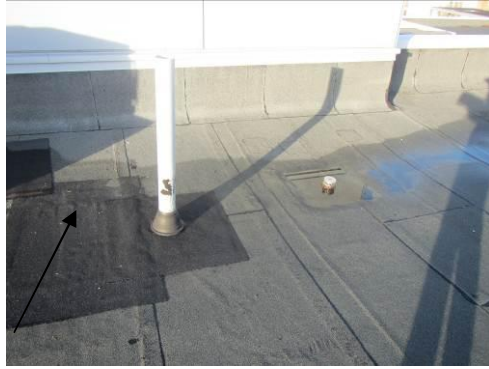
Kuva 52. WC-tilan yläpuoli katolla.
