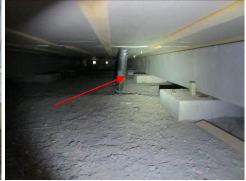
Kuva 78. Aistinvaraisesti tarkasteltuna alapohjan ryömintätilan tuuletus on hyvä ja tila on kuiva.
