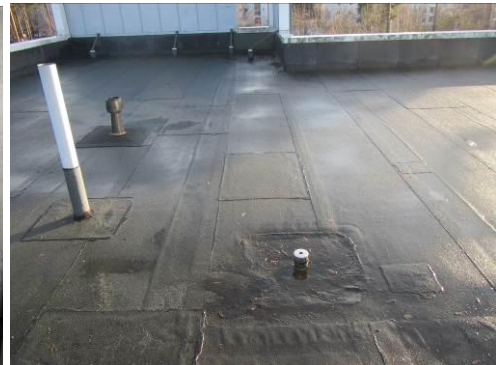
Kuva 46. Avauskohta RAK8 katolta kuvattuna.
