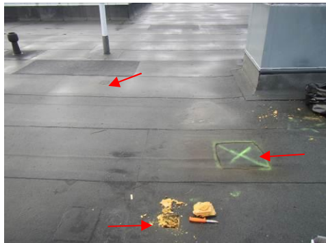
Kuva 36. Rakenneavauskohdat RAK4 (ylin nuoli), RAK 2 (kesk.) ja RAK7 (alin nuoli).
