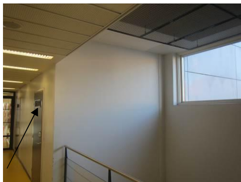
Kuva 50. Rakenneavauskohta RAK9. WC-tilan kattoon.
