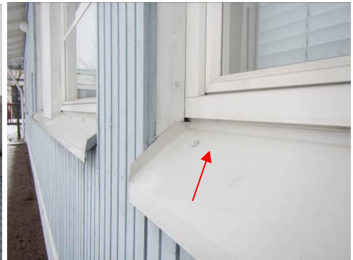
Kuva 73. Ikkunapellitusten kallistukset ovat hyvät.
