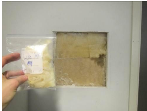
Kuva 39. Rakenneavauskohta RAK5 ja mikrobinäyte WJO M5.
