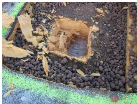
Kuva 32. Mikrobinäyte WJO M2 otettiin avauksesta RAK2.
