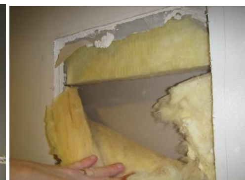
Kuva 42. Myös rakenneavauksessa RAK6 villa ja kipsilevy vaikuttavat kuivilta.
