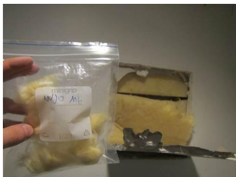
Kuva 41. Rakenneavauskohta RAK6 ja mikrobinäyte WJO M6.
