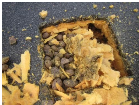
Kuva 38. Mineraalivilla on avauksessa RAK7 kostea.
