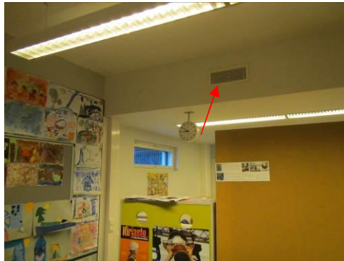
Kuva 5. Tila 2.29 on jaettu sermeillä/hyllyillä kahteen osaan. Tuloilmaeläimet sijaitsevat alasasketun katon otsapinnassa.
