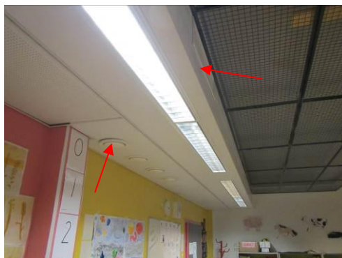
Kuva 9. Sekä tulo- että poistoilmaläimien sijaitsevat alasasketussa kotelossa.
