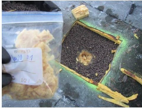
Kuva 28. Rakenneavaus RAK1 ja mikrobinäytteenotto WJO M1.
