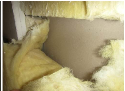
Kuva 40. Rakenneavauksessa RAK5 villa ja kipsilevy vaikuttavat kuivilta ja vaurioitumattomilta.
