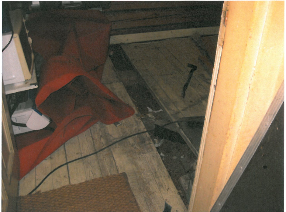
Kuva 7 Pohjakuvaan merkitty huone numero 3. Rakenneavauksessa on havaittavissa välipohjakannakkeiden kantosuunta.
