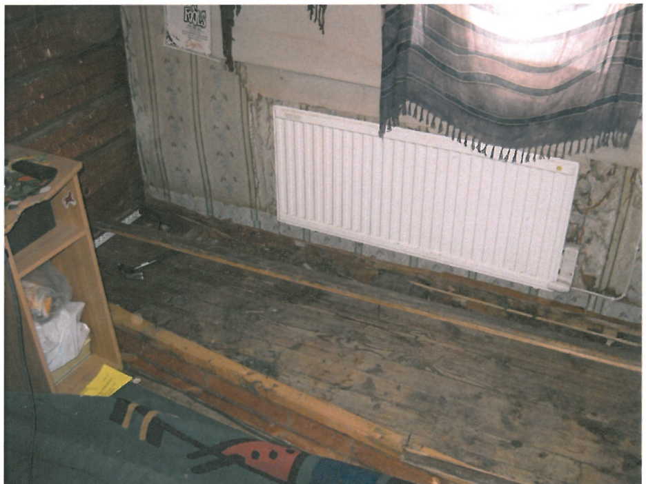
Kuva 8 Pohjakuvaan merkitty huone numero 3. Ulkoseinän viereinen rakenneavaus.
