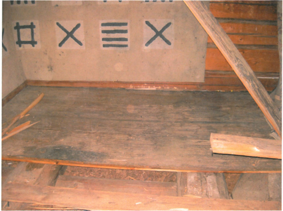
Kuva 4. Pohjakuvaan merkitty huone numero 1, avauksesta näkyy 1krs:n kantava väliseinä sekä ulokkeena toimivat välipohja kannattimet.
