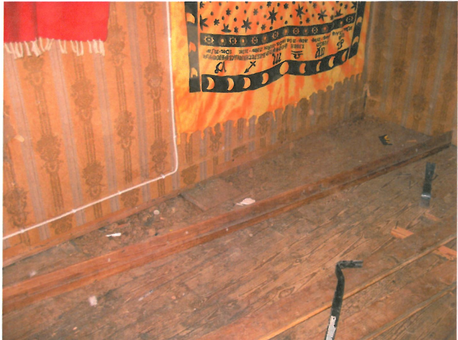
Kuva 5 Pohjakuvaan merkitty huone numero 1. Ulkoseinän viereinen rakenneavaus,
