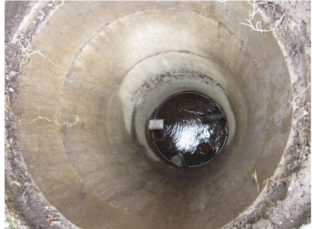
Kuva 8 Salaojan tarkastuskaivo.
