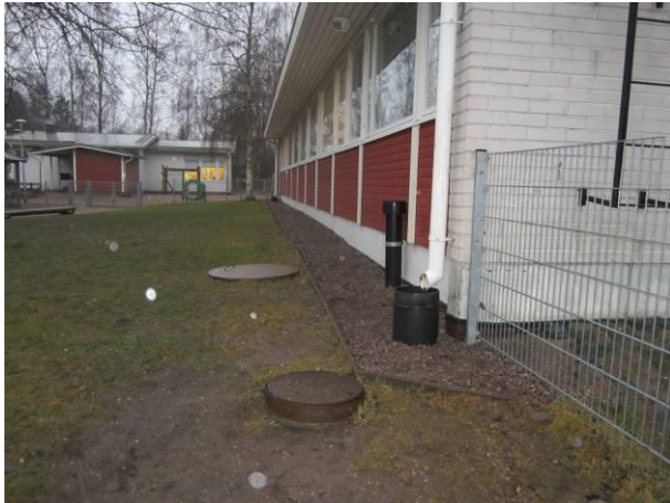
Kuva 1 Sepelikaista, viemärikaivo, rännikaivo ja taustalla betonikantinen salaojakaivo.
