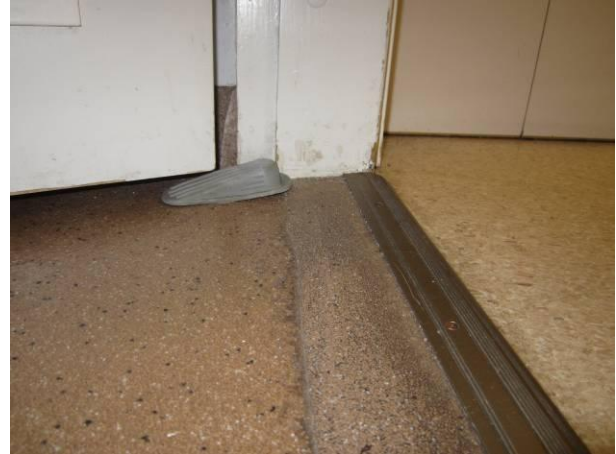
Kuva 26 Keittiön huono kynnyks
