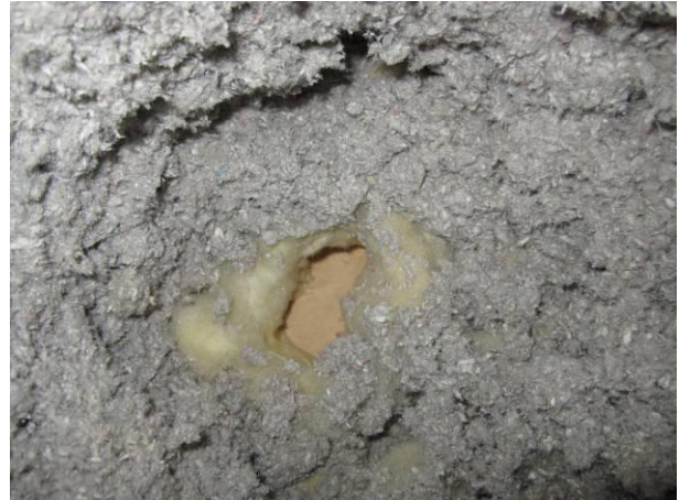
Kuva 20 Yläpohjassa on eristeenä puhallussellu- villaa ja sen alla lasivillaa.
