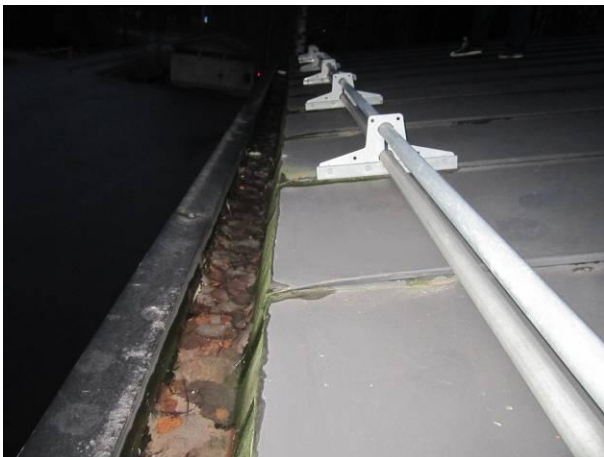
Kuva 21 Ränneissä lehtijätettä 30.11.2011
