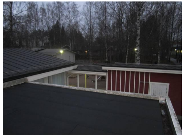
Kuva 22 Katosten ja ulkovaraston kattoja
