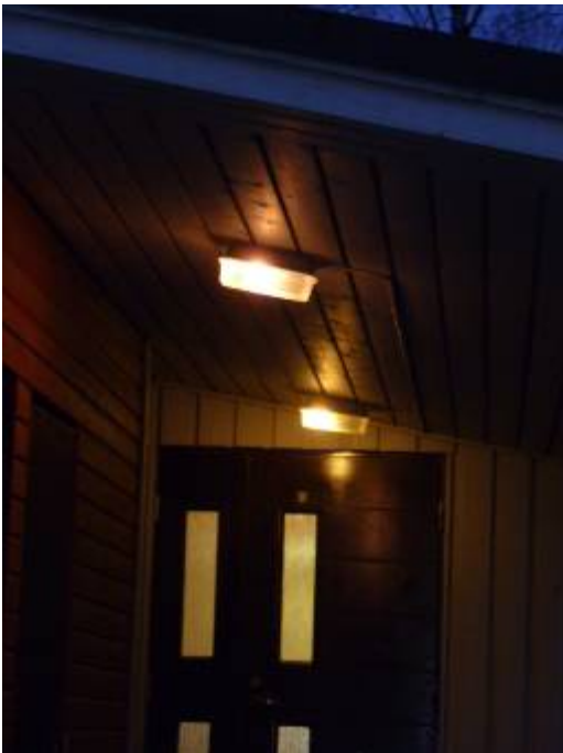
S-KUVA 2. Katoksen valaistus
