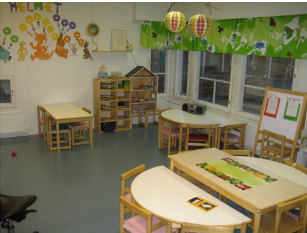
RAK-KUVA 6: Päiväkodin sisätilat ovat yleisilmeeltään tyydyttävässä kunnossa joskin mm. lattioiden muovimatot ovat pääosin alkuperäisiä ja siten mm. esteettisistä syistä edellyttävät kunnostamista.
