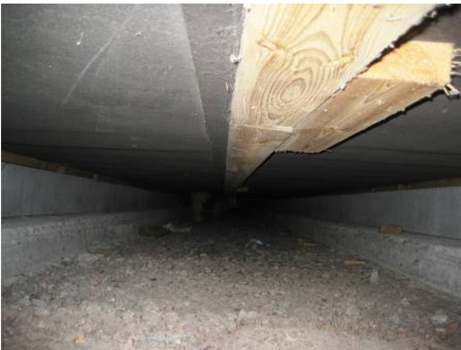
RAK-KUVA 2: Kuva tuulettuvasta alapohjatilasta. Rakenteista ei tehty havaintoja rakennusvaurioista.
