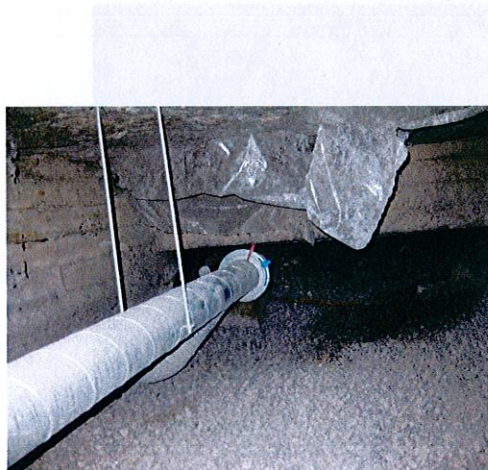
Kuva 7. Alapohjan ilmanvaihtokanava.
