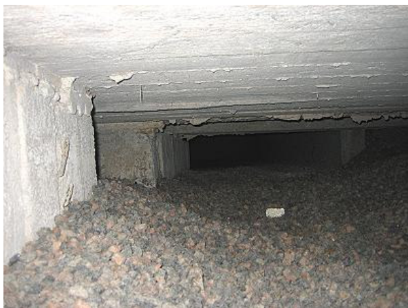
Kuva 11 Kulkuyhteys (matala) itäsvustan alustatilaan.
