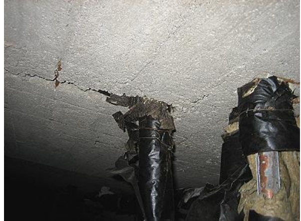
Kuva 2 Putkikanaalista nousuja alapohjalaatetaan.
