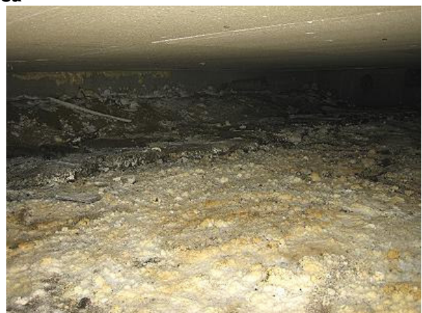
Kuva 18 Em. kohdilla alustatiloissa booraksia. Pinnoilla oli kuitenkin mikrobikasvustoja (tummat alueet).
