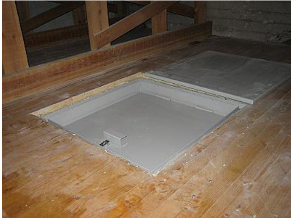
Kuva 7 Kulkuluukku näyttämön alta alustatilaan.
