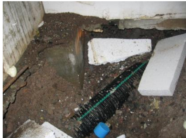
Kuva 28 Em. kulmauksessa salaojaputki toimii alapohjan kastelujärjestelmänä.
