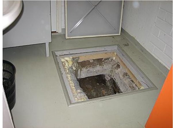
Kuva 14 Pukuhuoneen 133 kohdalta kulkuaukko alustatilaan.
