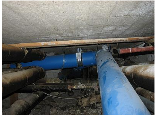
Kuva 4 A-osan päädyn putkikanaalia. Ahdasta.
