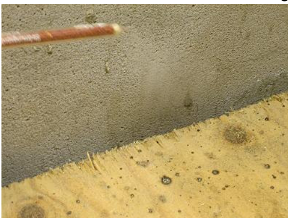
Kuva 17 C-osan luokkatilojen kohdilla alustatilat olivat alipaineiset.
