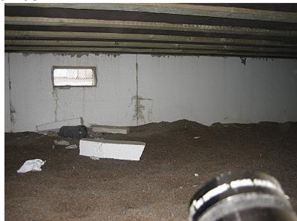
Kuva 24 Sokkelirakenteen sisäpuolella on eristeenä polystyreenilevyt.
