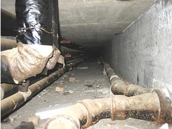
Kuva 1 Putkikanaali. Puuta yms.
