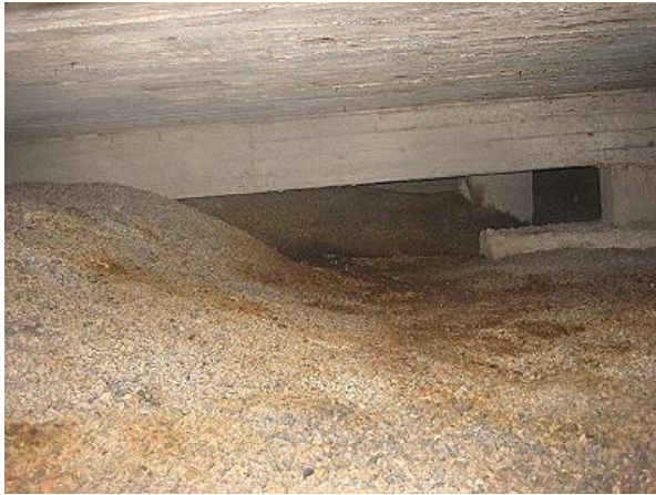
Kuva 9 Liikuntasalin alustatilassa oli mikrobikasvustoja (ruskeat alueet).
