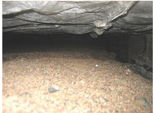
Kuva 16 Täyttönä oli hiekkaa/ soraa. Korkeus oli noin 200 mm. Betonilaatan alapuolella on muovia.
