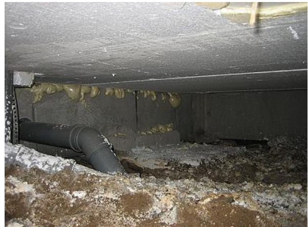
Kuva 22 Liittymiä oli tiivistetty paisuvalla polyuretaanivaahdolla.
