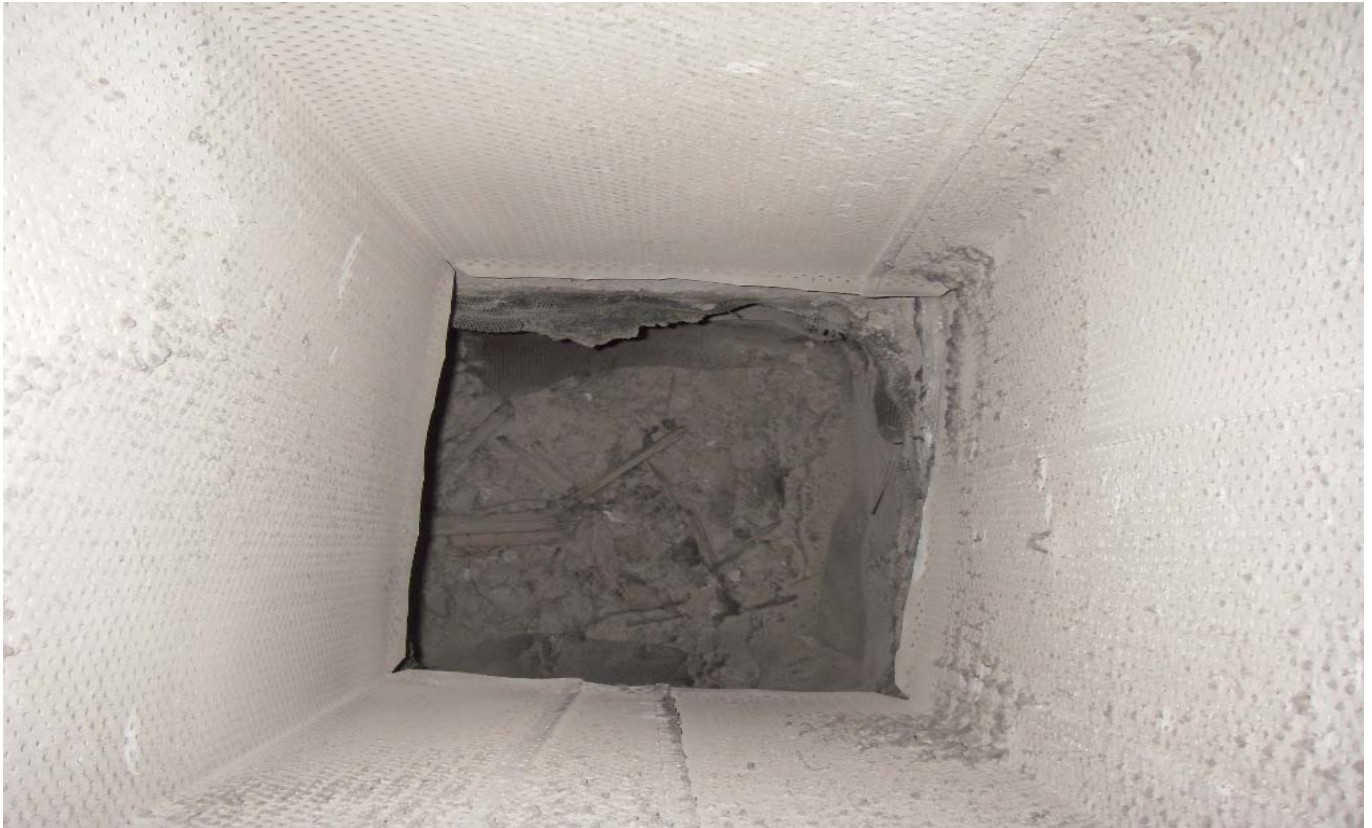
KUVA 5. Liikuntasalin poistoilmakanava on melko pölyinen.
