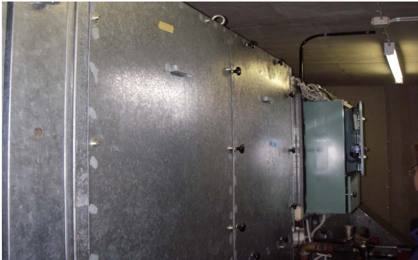
KUVA 1. Ilmastointikone on alkuperäinen Ilmateollisuuden valmistama ns. pakettikone.
