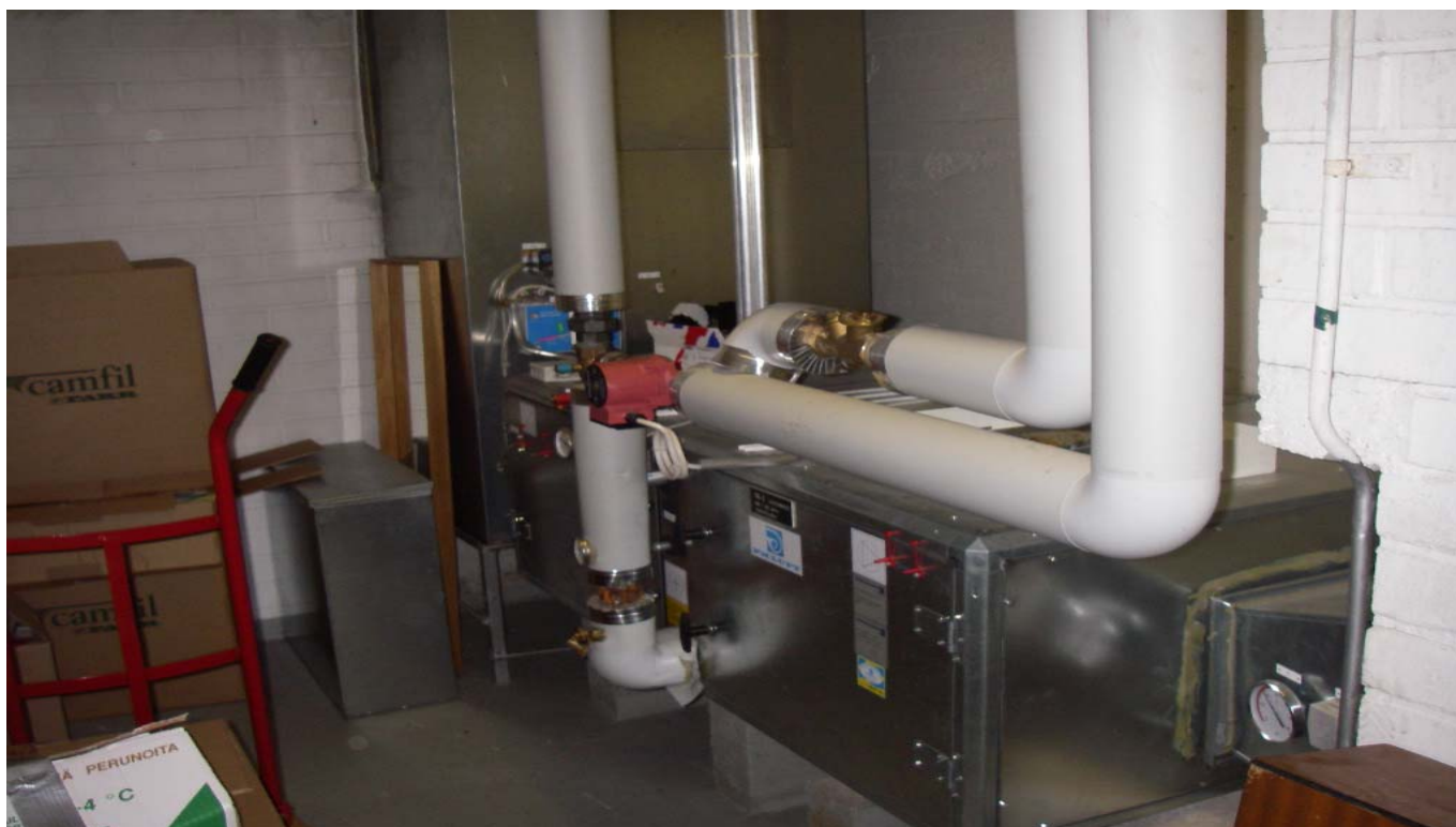
KUVA 2. Liikuntasalin ilmastointikone on uusittu PM- Luft valmistama ns. pakettikone.
