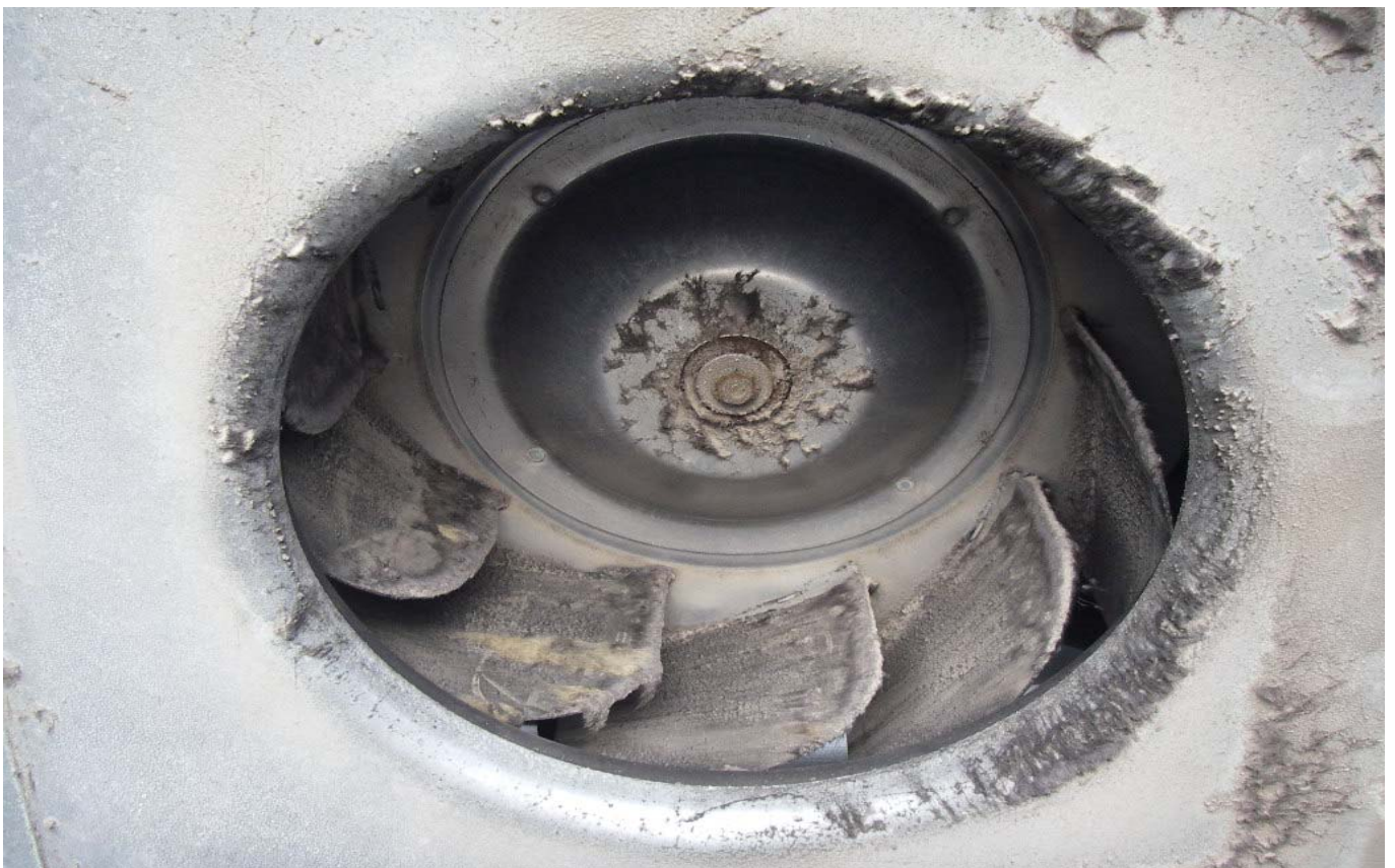
KUVA 4. Liikuntasalin huippumuri on melko pölyinen.
