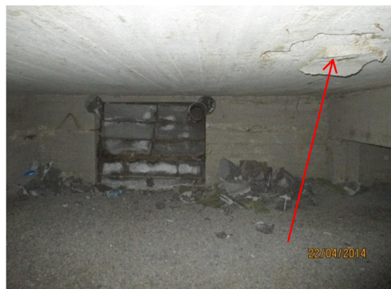
Kuvat 4a ja b. Kuvassa a on näyttämön lähellä oleva työaukko, jonka reunojen kautta on ilmayhteys perusmuurin sokkelihalkaisuun ja edelleen ylös ulkoseinään. Perusmuurin läpi on tuotu korvausilmaputki. Kuvassa b on väestönsuojan lähellä oleva työaukko, jonka harkkomuuraus on märkä. Katossa on nuolen osoittamassa kohdassa salin kiinnikejalan kohdalla oleva hauraalta vaikuttava valu, josta voi olla ilmayhteys saliin. Samanlaisia valupurseita on muitakin.
