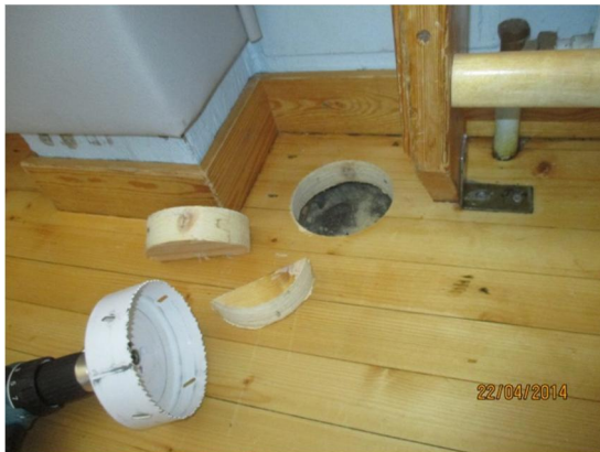
Kuvat 5a ja b. Kuvassa a on rakenneavauspaikka ulkoseinän vierellä. Kuvassa b on mineraalivilla alla oleva muovi, joka alla on betonilaatta. Materiaalit olivat kuivia.
