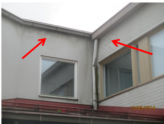
Kuvat 17a ja b. Kuvassa a on vuotojälkiä sisäpihan räystäään alla käytävän kohdalla, sekä v. 1968 laajennusosan tiiliseinällä. Kuvassa b on ulkoreunaltaan laho karmi musiikkiluokan kohdalla. Karmi oli tarkastushetkellä kuiva.
