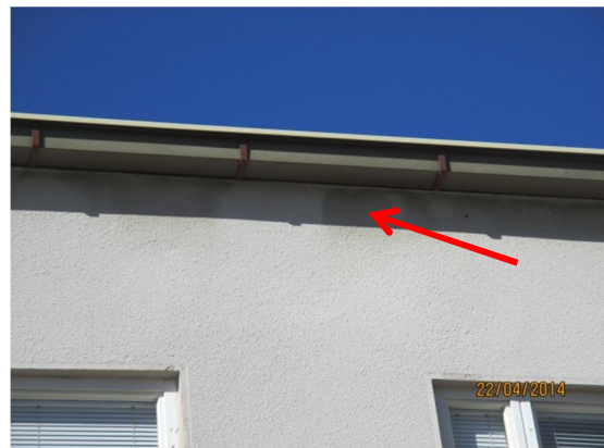
Kuvat 16a ja b. Kuvassa a on .musiikkiluokan kulmalla vuotojälkiä rännin alla sekä rappaukseen tehty avonainen liikuntasauma. Kuvassa b on musiikkiluokan alueella olevia muita räystäään vuotojälkiä.
