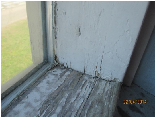
Kuvat 9a ja b. Kuvassa a on kosteusvauriojälkiä ikkunankarmissa ja pölyä. Kuvassa b on välinevaraston kulunut ja erittäin pahalle haiseva voimistelumatto..
