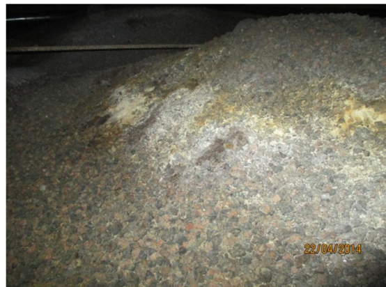
Kuvat 3a ja b. Kuvassa a on tyypillistä alustatilaa, ja poistoilmakanava. Paikoin sepelin pinnalla on selvää mikrobikasvua. Kuvassa b on mikrobikasvua aivan kulkuluukun lähellä.
