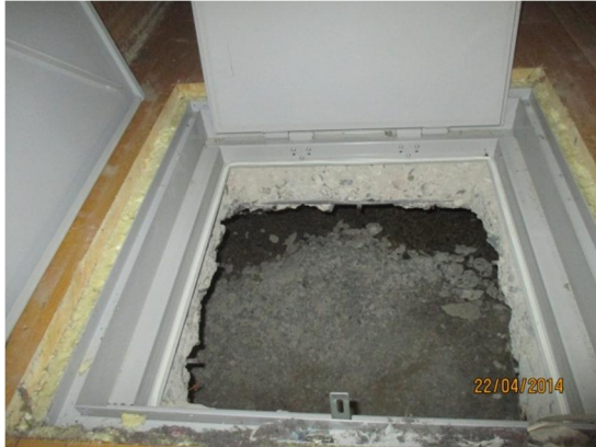
Kuvat 2a ja b. Kuvassa a on kulkuluukku näyttämön alla. alemmassa luukussa on tiivistys, mutta luukku ei kiristy tiiviiksi. Kuvassa b on vain polyuretaanilla betoniin kiinnitetty luukku, jonka liittymä ei ole ilmatiivis. Asia varmistettiin merkkiainekokeen avulla.
