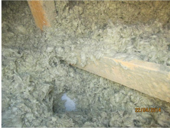
Kuvat 23a ja b. Kuvassa a on. yläpohjan puhallusvillaeristeen alla betonia, höyrynsulkumuovia ei havaittu. Kuvassa b on ulkoseinän yläosalla räystäskourun ali oleva kapea rako.
