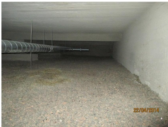
Kuvat 3a ja b. Kuvassa a on tyypillistä alustatilaa, ja poistoilmakanava. Paikoin sepelin pinnalla on selvää mikrobikasvua. Kuvassa b on mikrobikasvua aivan kulkuluukun lähellä.
