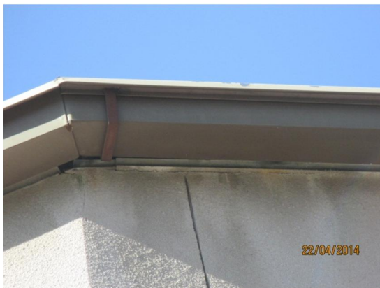
Kuvat 16a ja b. Kuvassa a on .musiikkiluokan kulmalla vuotojälkiä rännin alla sekä rappaukseen tehty avonainen liikuntasauma. Kuvassa b on musiikkiluokan alueella olevia muita räystäään vuotojälkiä.
