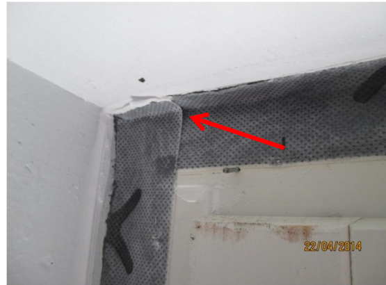
Kuvat 15a ja b. Kuvassa a on .merkkiainekoe, jossa havaittiin ulkoseinän eristetilaan syötetyn kaasun tulevan ikkunaliittymien kulmista. Kuvassa b on irrotettu ikkunaliittymän listoja, joiden alla vuotopaikoiksi havaittiin tiivistysnauhojen risteymät ja osin niiden reunaliittymät karmiin tai betoniseinään.
