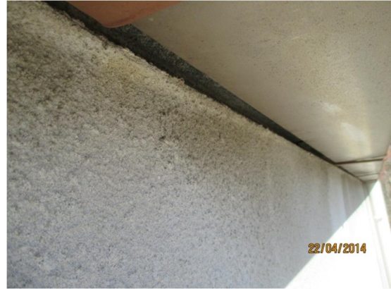
Kuvat 23a ja b. Kuvassa a on. yläpohjan puhallusvillaeristeen alla betonia, höyrynsulkumuovia ei havaittu. Kuvassa b on ulkoseinän yläosalla räystäskourun ali oleva kapea rako.
