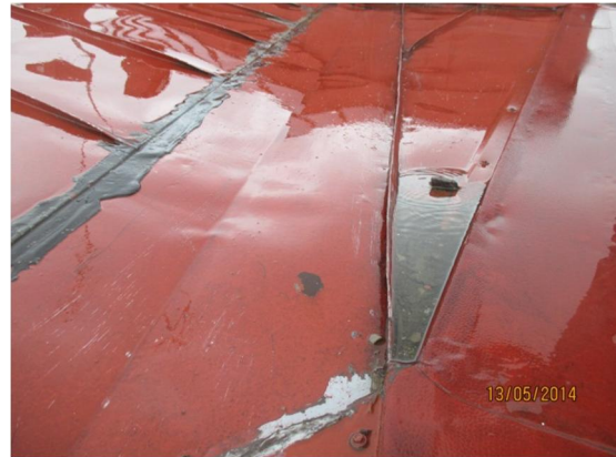
Kuvat 24a ja b. Kuvassa a on. laajennusosien välinen jiiri, jonka pellitykseen on tehty tiivistyskittauksia. Kuvassa b on jiiirin rivipeltiväliin padottunutta vettä.
