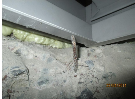
Kuvat 2a ja b. Kuvassa a on kulkuluukku näyttämön alla. alemmassa luukussa on tiivistys, mutta luukku ei kiristy tiiviiksi. Kuvassa b on vain polyuretaanilla betoniin kiinnitetty luukku, jonka liittymä ei ole ilmatiivis. Asia varmistettiin merkkiainekokeen avulla.
