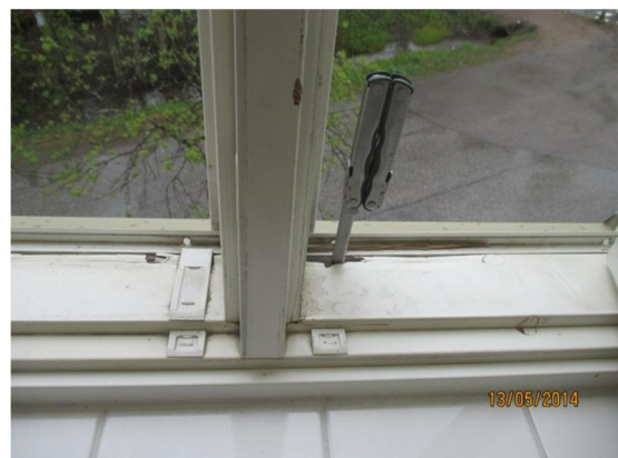
Kuvat 17a ja b. Kuvassa a on vuotojälkiä sisäpihan räystäään alla käytävän kohdalla, sekä v. 1968 laajennusosan tiiliseinällä. Kuvassa b on ulkoreunaltaan laho karmi musiikkiluokan kohdalla. Karmi oli tarkastushetkellä kuiva.
