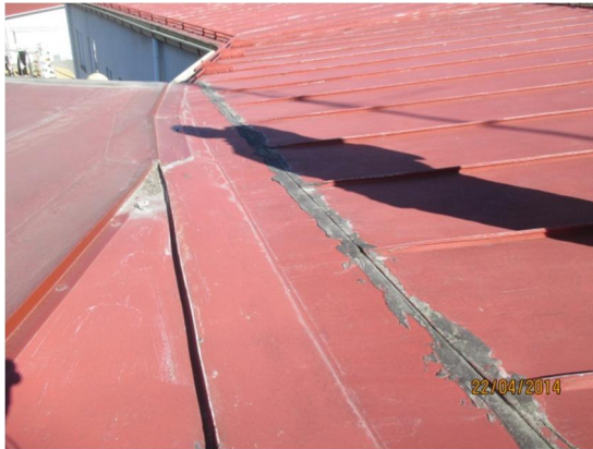
Kuvat 24a ja b. Kuvassa a on. laajennusosien välinen jiiri, jonka pellitykseen on tehty tiivistyskittauksia. Kuvassa b on jiiirin rivipeltiväliin padottunutta vettä.
