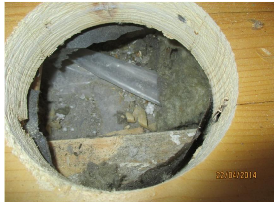
Kuvat 5a ja b. Kuvassa a on rakenneavauspaikka ulkoseinän vierellä. Kuvassa b on mineraalivilla alla oleva muovi, joka alla on betonilaatta. Materiaalit olivat kuivia.
