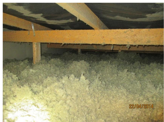
Kuvat 22a ja b. Kuvassa a on yleiskuva v. 1992 laajennusosan vesikatolta.. Kuvassa b on yläpohjaontelo, joka on hyvin matala räystäään lähellä. Aluskatteen räystääsläittymää ei päästy tutkimaan..
