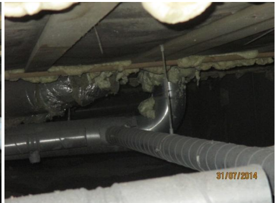
Kuvat 34a ja b. Kuvassa a on lounaispuolella keskialueen lähellä olevaa alustatilaa. Maanpinta on osin märkä tai kostea. Katon levyissä on kupruja ja vaaleaa värjäytymää. Kuvassa b on alustatilan ilmanvaihtokanava läpivienti alapohjan läpi, joka vaikutti epätiiviyttä.
