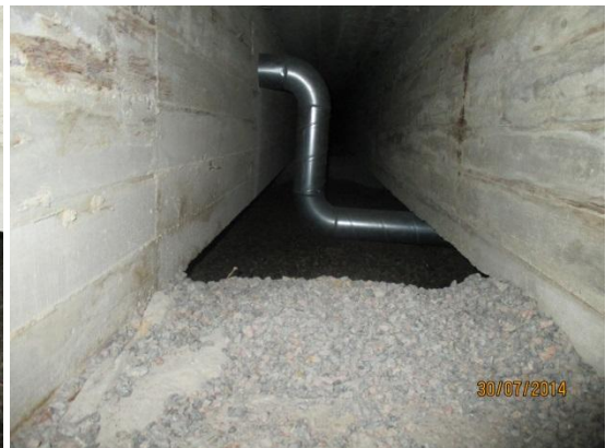
Kuvat 16a ja b. Kuvassa a on C-lohkon puolelta johtava kulkureitti D-lohkoon peruspalkin ja käytävän putkikanaalin ali, jonka kautta on tuotu myös poistoilmakanava C-lohkoon. Kuvassa b on käytävän alla olevan putkitunnelin ja peruspalkin välinen onkalo, jonka kautta on asennettu ilmanpoistokanava putkitunnelin seinän läpi.
