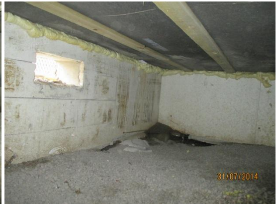
Kuvat 33a ja b. Kuvassa a on koillispuolella sisäpihan puoleista alustatilaa. Kattoon on ripustettu tuloilmakanava. Kuvassa b on koillispuolella kulma, jossa on ulkopuolelta tulevaa kosteutta. Katon tuulisuojalevyissä on kupruja ja vaaleaa värjäytymää. V. 2006 kartoituksessa pohjamaa oli vesimärkä.
