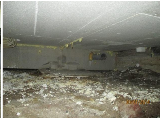
Kuvat 26a ja b. Kuvassa a on hammashoitolan ja v. 1969 laajennusosan D-lohkon välisen palkin läpi tuotu ilmanpoistoputken pää. Kanavaa on kuristettu säätämällä. Kuvassa b on ulkoseinän sokkelipalkin läpi tuodun korvausilmaputken pää. Sokkelipalkki on niin matala, että sen alareuna on alustatilan maanpintaa ylempänä.
