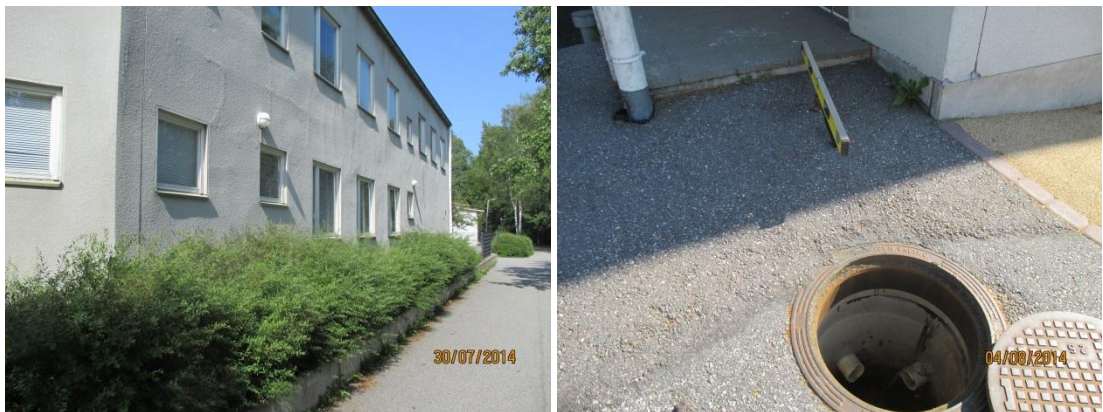
Kuvat 30a ja b. Kuvassa a on kaakkoissivun istutusallas, jonka istutusallas voi padottaa vettä. Kuvassa b on sisäpihan puoleinen salaojan tarkastuskaivo, jossa salaojan juoksupinnasta on maanpintaan n. 70 cm ja lattiapintaan n. 110 cm, joten alustatilan maanpinta on lähellä pohjatäyttöä.
