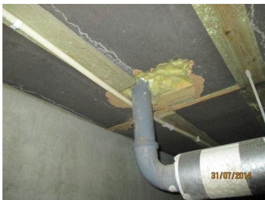
Kuvat 35a ja b. Kuvassa a on tiivistämätön viemärin läpivienti, joita oli useita eri puolilla alustatilaa. Kuvassa b on lounaispuolella keskialueen alustatilaa, jossa sepeli on paikoin kostea ja tasaamatta.
