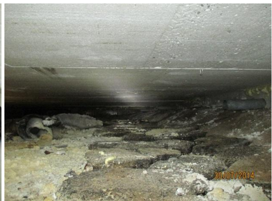
Kuvat 27a ja b. Kuvassa a on käytävällä oleva alkuperäinen alustatilan kulkuluukku, joka on vanerirakenteinen. Luukun alareunassa on tiiviste. Pohjalla on lämpöeristetty luukku. Kuvassa b on puutyösalin alla olevaa alustatilaa, jonka pohjalle on jätetty asfalttipalasia, Perusmuurin vierellä maanpinta nousee.
