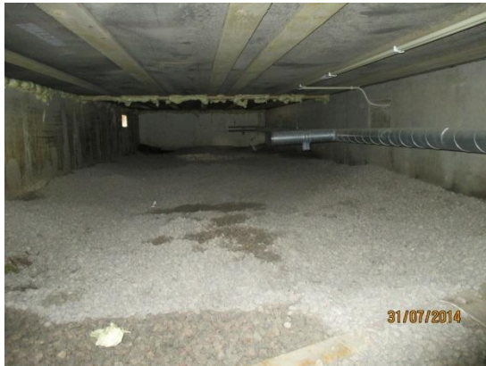
Kuvat 33a ja b. Kuvassa a on koillispuolella sisäpihan puoleista alustatilaa. Kattoon on ripustettu tuloilmakanava. Kuvassa b on koillispuolella kulma, jossa on ulkopuolelta tulevaa kosteutta. Katon tuulisuojalevyissä on kupruja ja vaaleaa värjäytymää. V. 2006 kartoituksessa pohjamaa oli vesimärkä.
