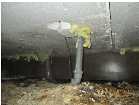
Kuvat 25a ja b. Kuvassa a on epätiivitä läpivientejä. Lohkojen välinen elementtipalkki on sivultaan märkä. Kuvassa b on puulevyin maanpinnasta tuettuja viemäreitä hammashoitolan alla. Vaalea kerros maanpinnalla on booraksia.
