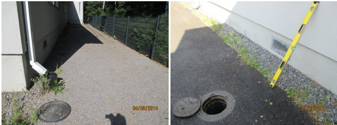
Kuvat 37a ja b. Kuvassa a on lounaispäädyn salaojan tarkastuskaivo, jossa maanpinnasta juoksupintaan on n. 60 cm. Kuvassa b on sisäpihan tarkastuskaivo, jossa maanpinnasta salaojan juoksupintaan on n. 90 cm. Tuuletussäleikön alapinta on lähellä maanpintaa. Sepelikaistan kautta valuu pintavesiä maaperään. Sokkelin korkeus on n. 50 cm ja sokkelin alareunasta on lattiapintaan n. 32 cm.
