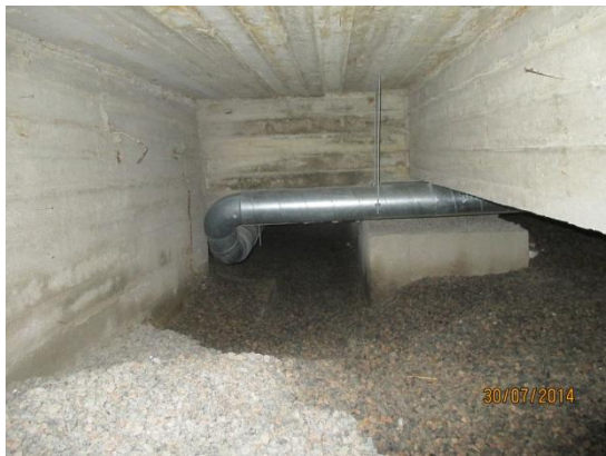
Kuvat 16a ja b. Kuvassa a on C-lohkon puolelta johtava kulkureitti D-lohkoon peruspalkin ja käytävän putkikanaalin ali, jonka kautta on tuotu myös poistoilmakanava C-lohkoon. Kuvassa b on käytävän alla olevan putkitunnelin ja peruspalkin välinen onkalo, jonka kautta on asennettu ilmanpoistokanava putkitunnelin seinän läpi.
