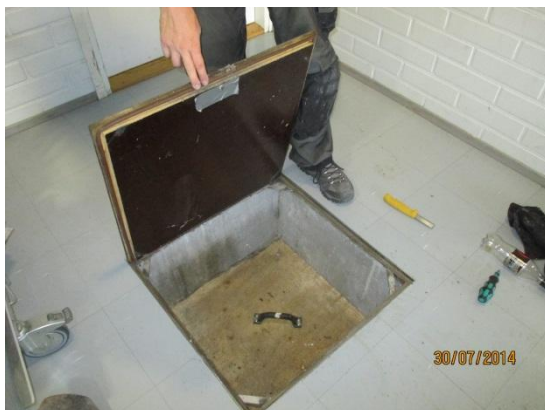
Kuvat 27a ja b. Kuvassa a on käytävällä oleva alkuperäinen alustatilan kulkuluukku, joka on vanerirakenteinen. Luukun alareunassa on tiiviste. Pohjalla on lämpöeristetty luukku. Kuvassa b on puutyösalin alla olevaa alustatilaa, jonka pohjalle on jätetty asfalttipalasia, Perusmuurin vierellä maanpinta nousee.
