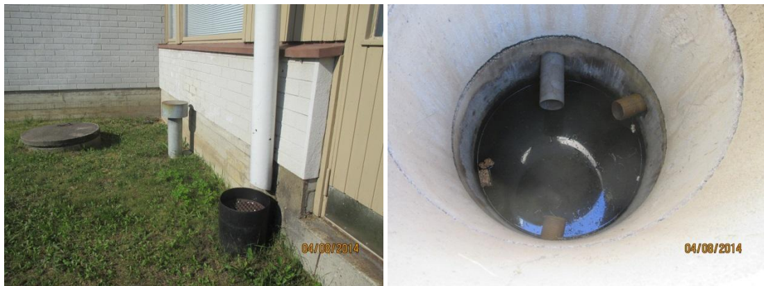
Kuvat 21a ja b. Kuvassa a on D-lohkon länsisivua, jossa syöksytorvivesi menee pääosin rännikaivon ohi. Kulmauksessa on maanpinnassa painauma ja salaojien tarkastuskaivo, ks. kuva b.. Kuvassa b on salaojan tarkastuskaivo, jonka salaojien juoksupinta on n. 120 cm maanpinnasta. Purkuviemäri lähtee rakennuksen alle.
