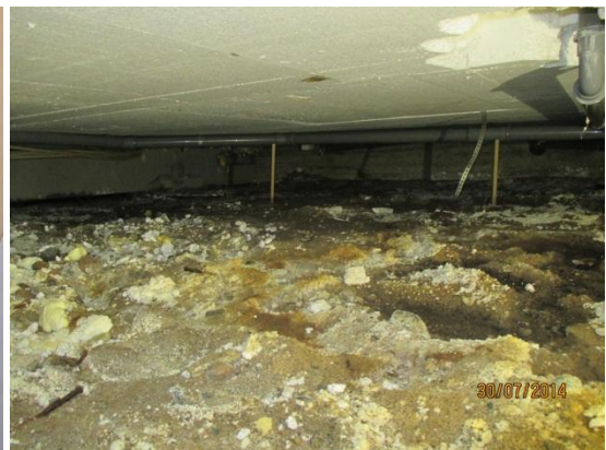
Kuvat 24a ja b. Kuvassa a on hammashoitolan uusittu kaasutiivis luukku. Alle jätetty eristysluku lähti pois vain rikkomalla. Kuvassa b on hammashoitolan alustatilan mikrobivaurioitunutta pohjaa, jossa on myös booraksia.
