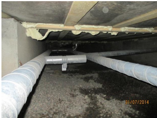
Kuvat 34a ja b. Kuvassa a on lounaispuolella keskialueen lähellä olevaa alustatilaa. Maanpinta on osin märkä tai kostea. Katon levyissä on kupruja ja vaaleaa värjäytymää. Kuvassa b on alustatilan ilmanvaihtokanava läpivienti alapohjan läpi, joka vaikutti epätiiviyttä.
