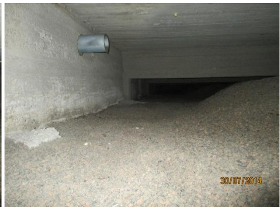
Kuvat 17a ja b. Kuvassa a on C- ja D-lohkoja palveleva ilmanpoistojärjestely, jossa poistoilma johdetaan perusmuurin läpi ulkoilmaan. Samasta kanavasta on haarotusputki myös v. 1992 laajennusosan hammashoitolan alla olevaan alustatilaan. Ulkoseinällä on umpeen muurattu työaukko. Maanpinta on kostea, Alustatilan kunto vaikuttaa olevan sama kuin v. 2006 kartoituksessa on havaittu. Kuvassa b on D-lohkon perusmuurin vierustaa ja korvausilmaputki.
