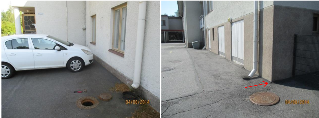
Kuvat 3a ja b. Kuvassa a on pohjoissivun rakennusvieret, jossa kallistukset ovat pois päin rakennuksesta. Kattosadevedet on viemäroity sadevesiviemäriin, joka on avatun tarkastuskaivon linjalla. Kuvassa b on eteläisivua, jossa kallistukset ovat pienehköt. Talon kulmalla on perusmuuria vasten sokkelilevy.
