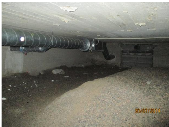
Kuvat 17a ja b. Kuvassa a on C- ja D-lohkoja palveleva ilmanpoistojärjestely, jossa poistoilma johdetaan perusmuurin läpi ulkoilmaan. Samasta kanavasta on haarotusputki myös v. 1992 laajennusosan hammashoitolan alla olevaan alustatilaan. Ulkoseinällä on umpeen muurattu työaukko. Maanpinta on kostea, Alustatilan kunto vaikuttaa olevan sama kuin v. 2006 kartoituksessa on havaittu. Kuvassa b on D-lohkon perusmuurin vierustaa ja korvausilmaputki.
