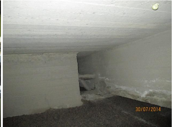
Kuvat 15a ja b. Kuvassa a on opetusvälinevarastossa oleva 2-osainen luukku alustatilaan. Luukusta tuli vahva ilmavirta sen ollessa auki. Luukun kautta on asennettu olosuhde- ja paine-ero-seurantamittausantureita alustatilaan. Kuvassa b on ahdas kulku-/ ilmayhteys B-lohkoon, sekä käytävän alla olevan putkitunnelin ali.
