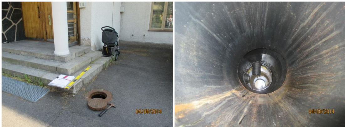
Kuvat 4a ja b. Kuvassa a pohjoissivun sisäänkäynnin kulmalla oleva salaojien tarkastuskaivo. Kuvassa b on em. tarkastuskaivo, joka on uudehko. Salaojat ovat nk. tuplasalaojaa. Maanpinnasta juoksupintaan on n. 185 cm.. Sokkelivierellä maanpinta on hieman lattiapintaa ylempänä.
