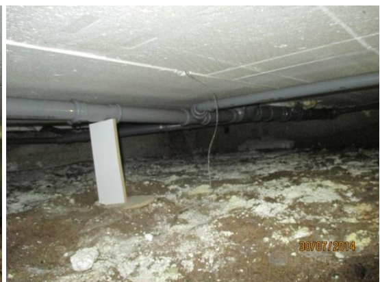
Kuvat 25a ja b. Kuvassa a on epätiivitä läpivientejä. Lohkojen välinen elementtipalkki on sivultaan märkä. Kuvassa b on puulevyin maanpinnasta tuettuja viemäreitä hammashoitolan alla. Vaalea kerros maanpinnalla on booraksia.
