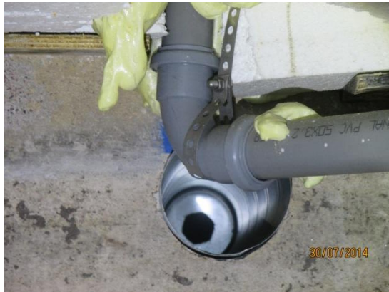
Kuvat 26a ja b. Kuvassa a on hammashoitolan ja v. 1969 laajennusosan D-lohkon välisen palkin läpi tuotu ilmanpoistoputken pää. Kanavaa on kuristettu säätämällä. Kuvassa b on ulkoseinän sokkelipalkin läpi tuodun korvausilmaputken pää. Sokkelipalkki on niin matala, että sen alareuna on alustatilan maanpintaa ylempänä.
