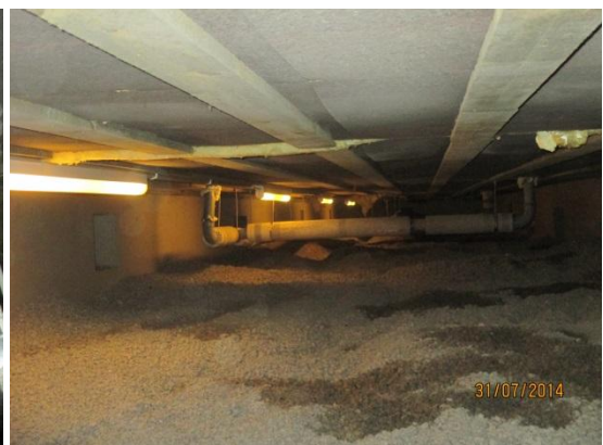
Kuvat 35a ja b. Kuvassa a on tiivistämätön viemärin läpivienti, joita oli useita eri puolilla alustatilaa. Kuvassa b on lounaispuolella keskialueen alustatilaa, jossa sepeli on paikoin kostea ja tasaamatta.
