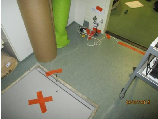
Kuvat 15a ja b. Kuvassa a on opetusvälinevarastossa oleva 2-osainen luukku alustatilaan. Luukusta tuli vahva ilmavirta sen ollessa auki. Luukun kautta on asennettu olosuhde- ja paine-ero-seurantamittausantureita alustatilaan. Kuvassa b on ahdas kulku-/ ilmayhteys B-lohkoon, sekä käytävän alla olevan putkitunnelin ali.
