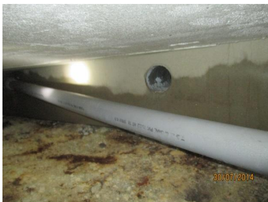
Kuvat 28a ja b. Kuvassa a on alaosaltaan märkä peruspalkki, jonka läpi on alustalohkojen välinen ilmanvaihtoreitti. Viemäri on tukematta pitkältä osuudelta. Kuvassa b on koekuoppa puutyösalin konehuoneen/ puuvaraston kohdalta. Hienoaineksia sisältävän sorapatjan paksuus on yli 20 cm.
