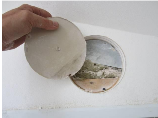
Kuva 44. Avaus SA2 kotelon sivuun, 50 mm villan takana on ontelolaatan sivu.
