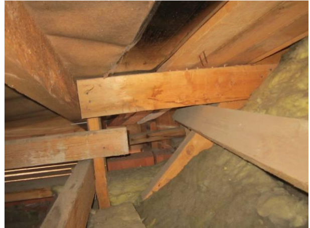
Kuva 22. Luokan 167 yläpuolisen jiirin alla oleva bitumikermi aluskatteen alla, räystäään lähellä on vuotojälkiä
