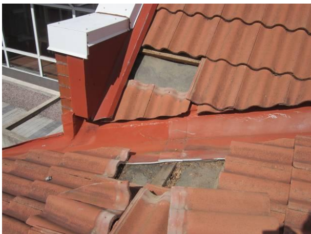
Kuva 5. Jiiriavaus luokan 167 kohdalla, jiiripellin lyhyt jatke, jossa lyhyt limitys
