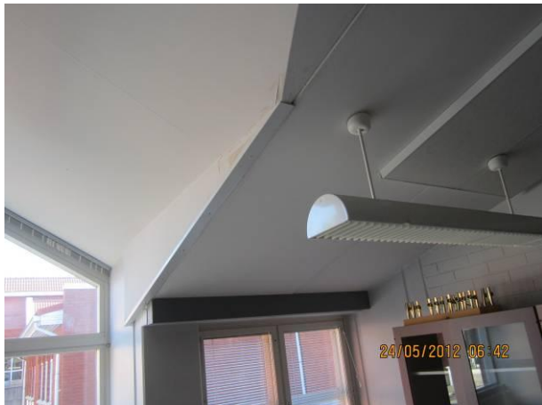
Kuva 39. Kipsilevyvaurioita tilassa 214
