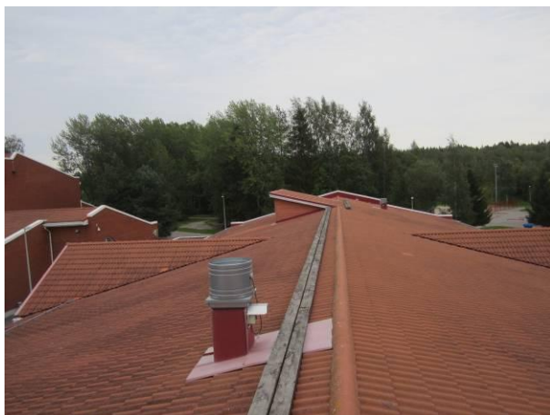
Kuva 29. Yleiskuva laajennusosan vesikatolta.
