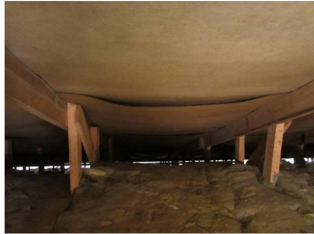
Kuva 12. Keskimääräistä eristystasoa, ontelo tuulettuu räystäiltä.
