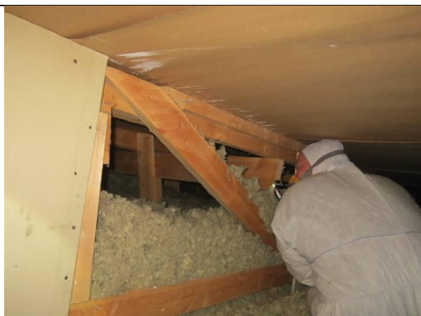
Kuva 37. Väliseinän 214 ja 215 yläpuolinen palokatko, josta poistettiin levy tilan 214 yläpuolisen jiirin tarkastusta varten.
