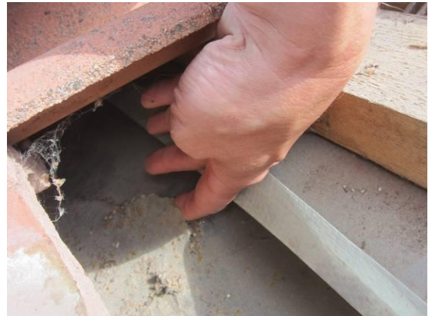
Kuva 10. Harjatiilen alla oleva revennyt aluskatepahvi tuulikaapin 170 yläpuolella. Alla on bitumikermi, ks. kuva 22 yläpohjassa.
