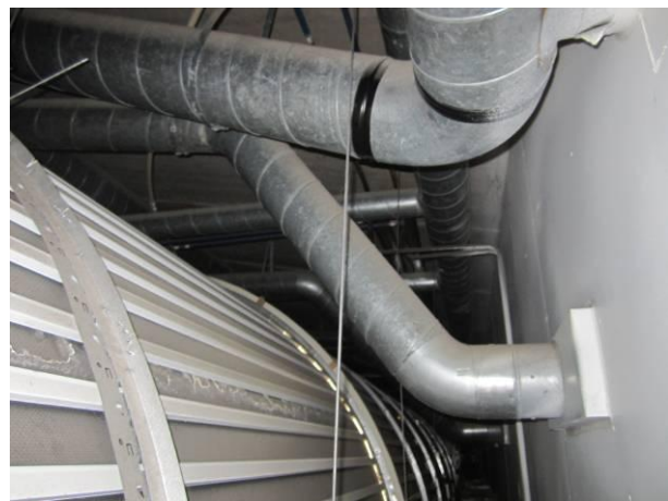
Kuva 28. Tuulikaapin 151 alakattotilan vuotojälkiä peltisäleiden vaimennusilloissa.
