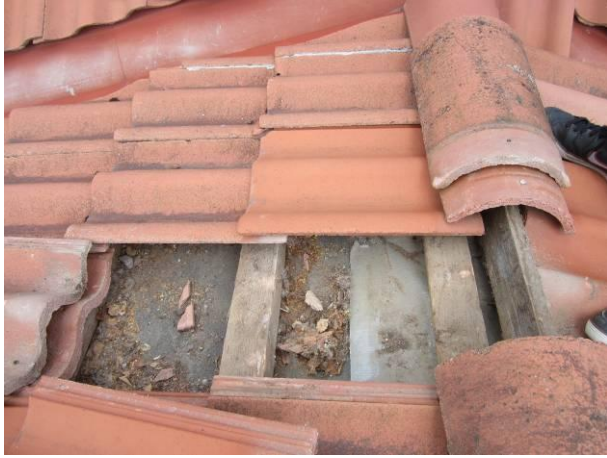
Kuva 7. Harjalta pääsee roskia, harjan yli on kuituvahvistettu muovialuskatekaistale.
