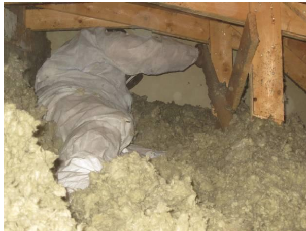
Kuva 36. Lähellä harjaa on eristetty kotelo, jonka vierellä ryömittiin.
