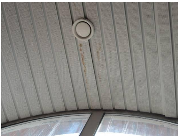
Kuva 27. Tuulikaapin 170 sälekaton vuotojälkiä, myös lasissa on vuotojälkiä.
