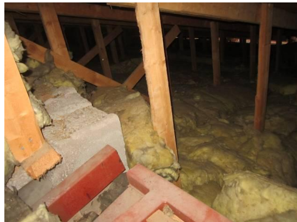
Kuva 20. Teräsrunkoa ja betonia esillä käytävän 152 ja käytävän 147 liittymässä.
