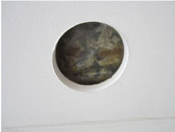
Kuva 43. Avaus SA1 tilan 214 kattoon, märkää villaa.
