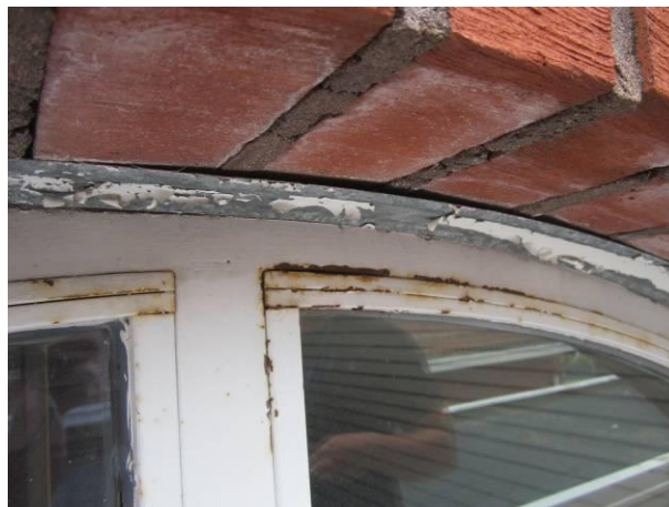
Kuva 4. Tuulikaapin kaari-ikkunan pielliittymissä on vuotojälkiä.
