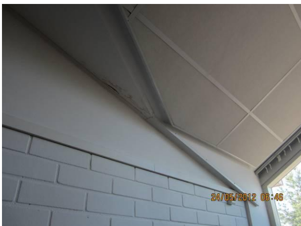
Kuva 41. Kipsilevyvaurioita tilassa 236
