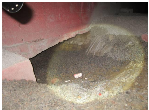
Kuva 24. Mikrobivaurioitunutta maata perustuspalkin alitusmontun reunoilla.
