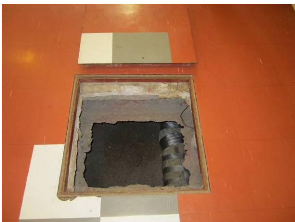
Kuva 23. Yksinkertainen tiivistämätön luukku, reunat ovat viimeistelemättä.
