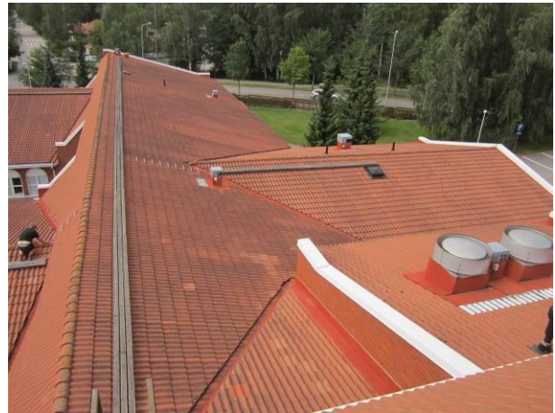
Kuva 2. Alkuperäisen osan käytävän ja ruokala-keittiön vesikatot, oikealla etualalla IV-konehuoneen vesikatto.
