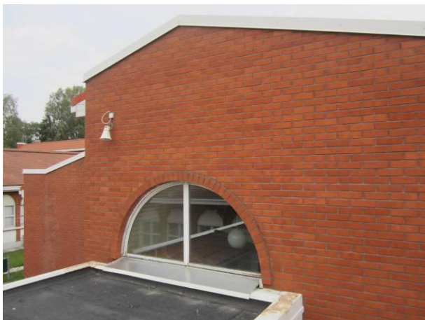
Kuva 3. Viistosateella kastuvia tiiliseiniä ja tuulikaapin 151 kaari-ikkuna.
