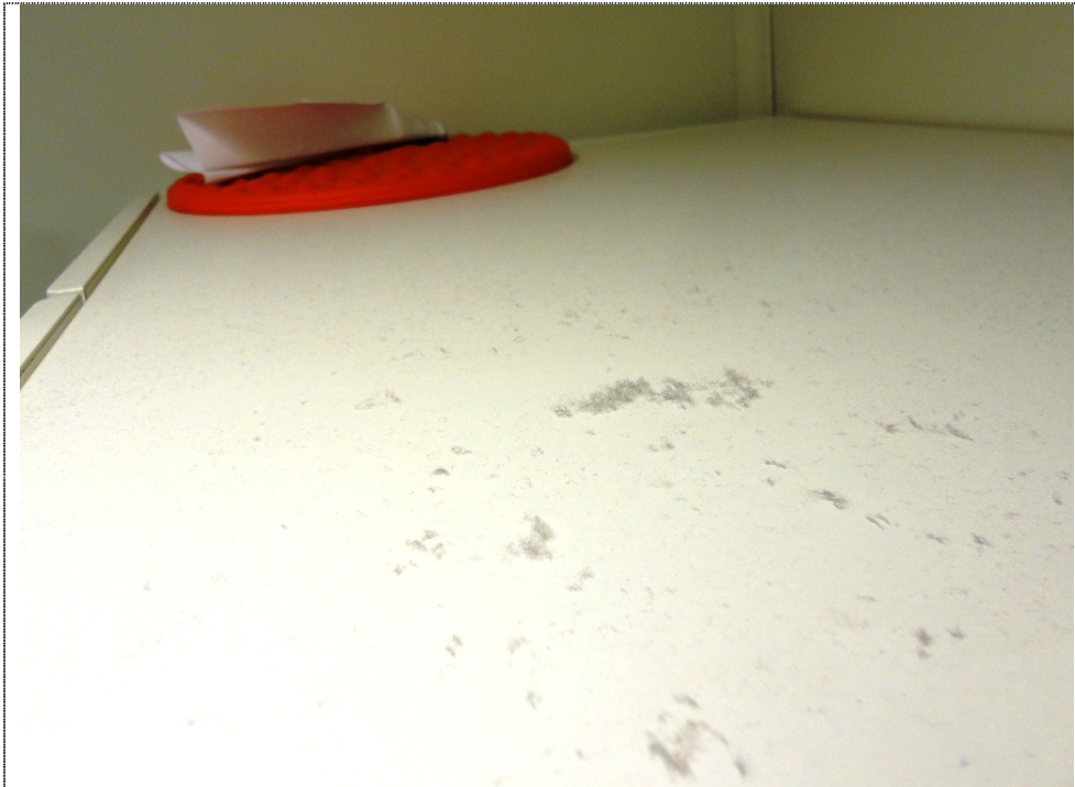
Kuva 19: Lepohuoneissa sänkykaappien päällä oleva pölykertymä on poikkeuksellisen suuri. Pöly nousee ilmaan suljettaessa kaapin ovi. Pöly leviää tällöin uudestaan oleskeluvyöhykkeelle.
