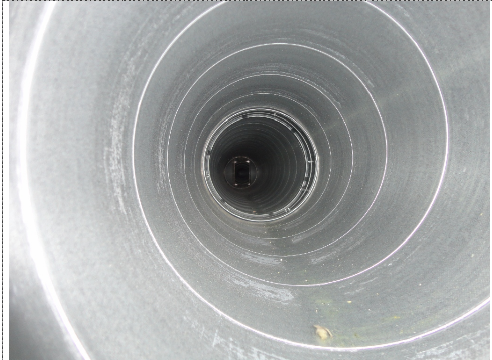
Kuva 13: Tuloilmakanavisto on visuaalisesti arvioiden kohtuullisen puhdas, pölykertymä alle P1 luokan puhdistusraja-arvon 2,0 g/m 2 . Kanavistossa on vähäisiä määriä rakennusaikaista likaa ja karkeaa ainetta, mikä ei vaikuta sisäilman laatuun.
