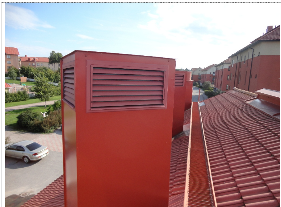
Kuva 4: Raitisilmasäleikön seulaverkko on toteutettu liian pienellä, 10 mm silmäkoolla, jolloin verkon jäätyminen on mahdollista. Suositeltava silmäkoko on 18 mm.
