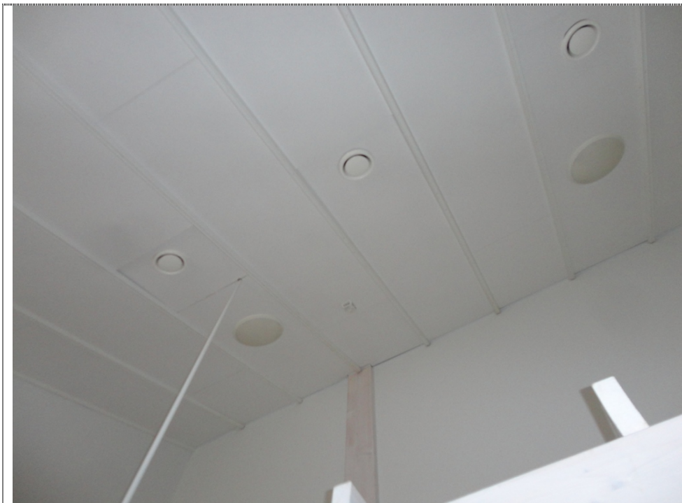
Kuva 8: Poistoilmaventtiilit lepohuoneen 109 katossa ovat puhtaat. Venttiilit on sijoitettu yli neljän metrin korkeuteen.
