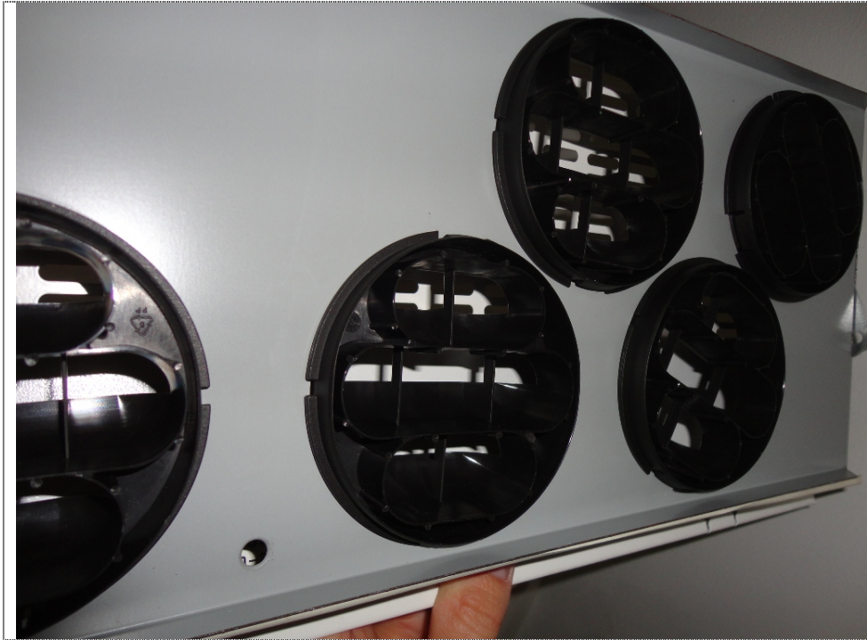
Kuva 7: Tuloilman suutinosä käytävän 111 laitteella on erittäin puhdas. Myös tuloilmalaatikon puhtaus on hyvää tasoa. Laatikon äänenvaimennusmateriaali on polyesteripohjainen.
