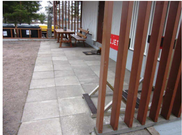
Kuva 7 Kallistus rakennuksesta poispäin.
