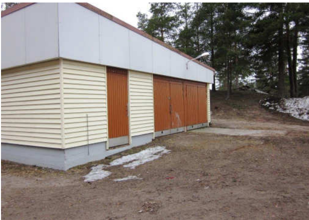
Kuva 4 Pintakallistus rakennuksesta poispäin.
