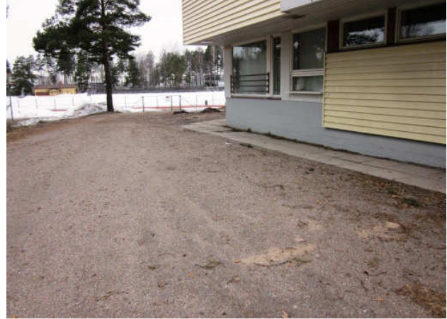
Kuva 2 Pinta viettää rakennukseen päin.
