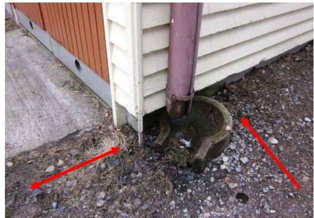
Kuva 5 Maanpinta tasainen tai kallistus rakennukseen päin.
