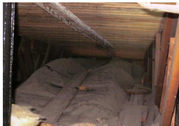
Kuva 6 2.kerroksisen osan yläpohjaonteloa.
