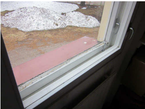
Kuva 12 Ulkopuite vaurioitunut.
