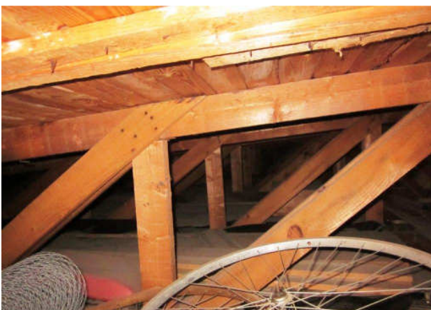
Kuva 5 1.kerroksisen osan yläpohjaonteloa.
