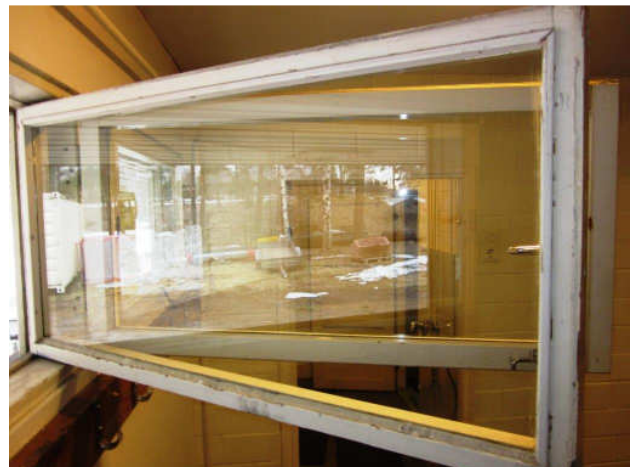
Kuva 13 Pukuhuoneen ikkunat ovat kuluneet mutta vaurioita ei havaittu.
