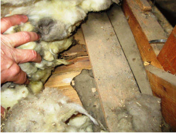
Kuva 7 Mineraalivillaeristeen alla tarkastuskohdalla laudoitus.
