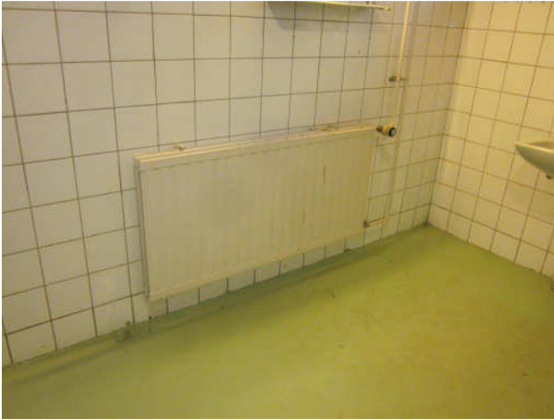
Kuva 16 Patterissa alkavaa ruostumista.
